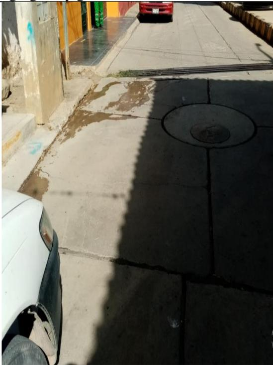
Progresiva 0+615 pulimiento de agregado y grietas lineales
