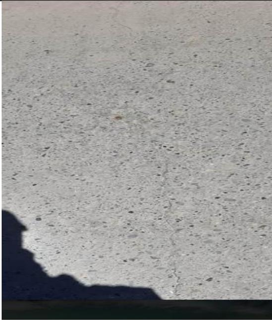
Progresiva 0+600 pulimiento de agregado y grietas lineales
