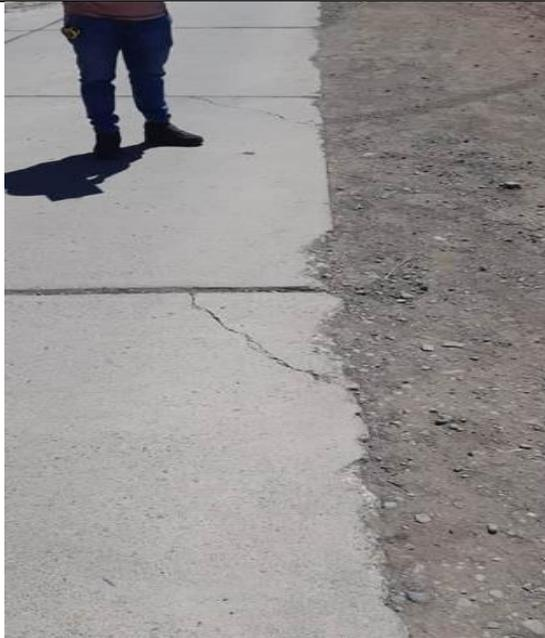
Progresiva 0+550 pulimiento de agregado y grieta lineal
