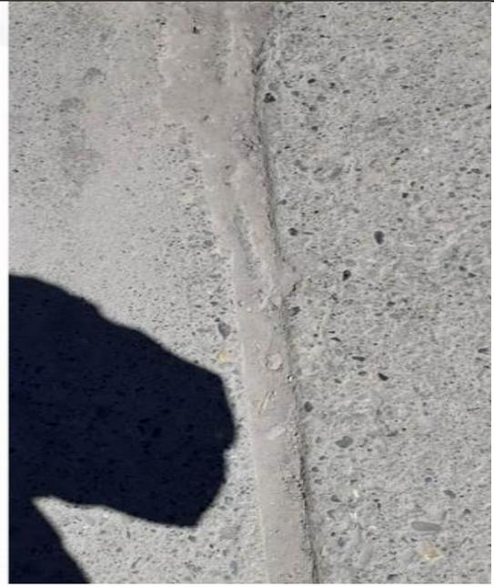
Progresiva 0+608 pulimiento de agregado y grietas lineales
