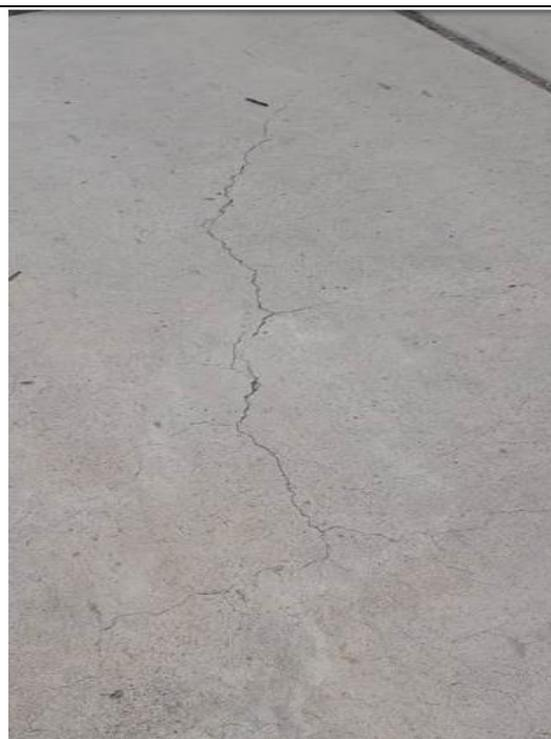
Progresiva 0+489 grieta lineal y pulimiento de agregado
