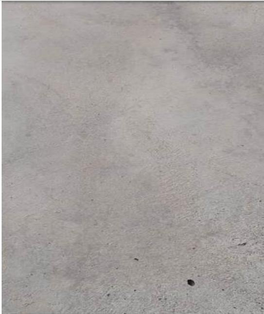
Progresiva 0+438 pulimiento de agregados
