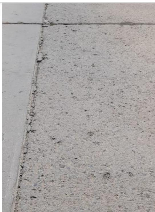
Progresiva 0+106 grieta lineal y pulimiento de agregado
