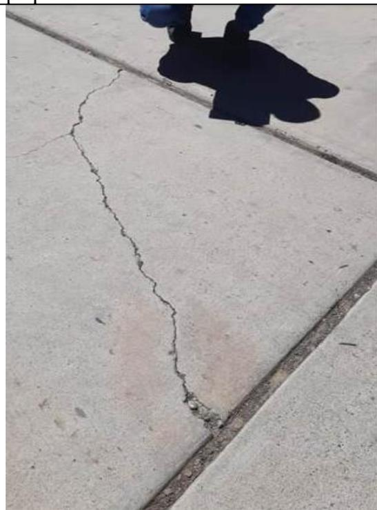
Progresiva 0+494 grieta lineal y pulimiento de agregados
