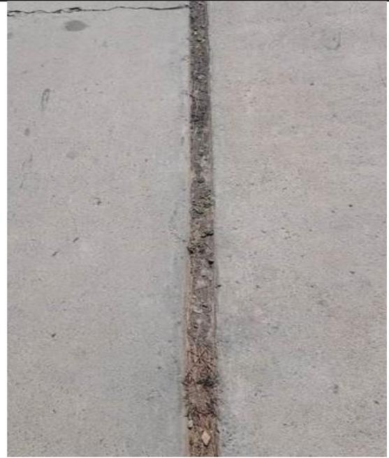
Progresiva 0+529 pulimiento de agregado, grieta lineal y desnivel de berma
