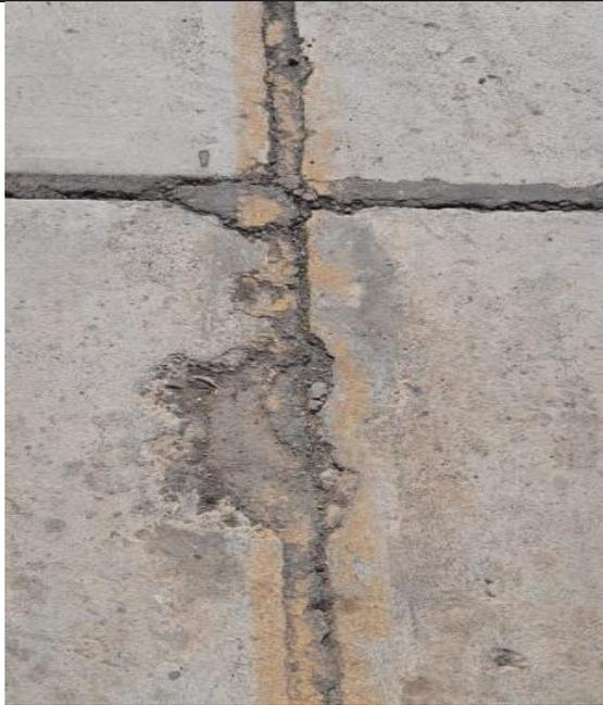
Progresiva 0+404 grieta lineal, parcheo grande y pulimiento de agregado
