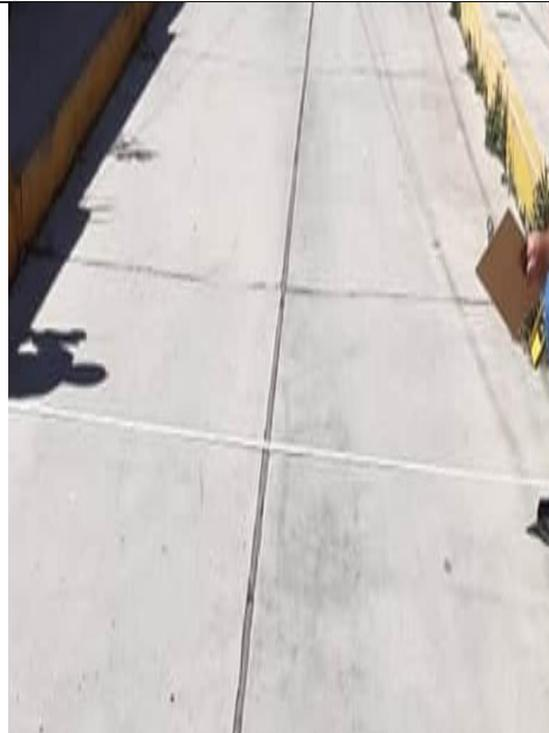
Progresiva 0+461 losa dividida y grieta lineales
