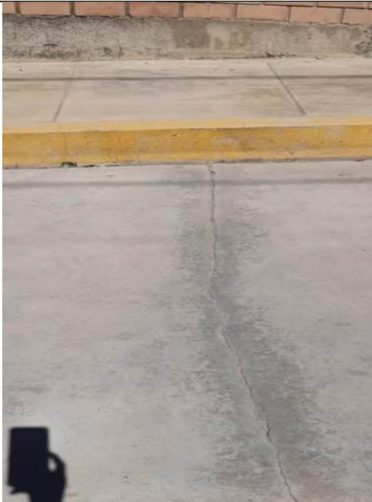
Progresiva 0+456 pulimiento de agregados y grietas lineales
