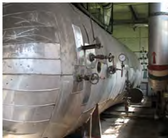
Slika 1: Izgled akumulatora pare
