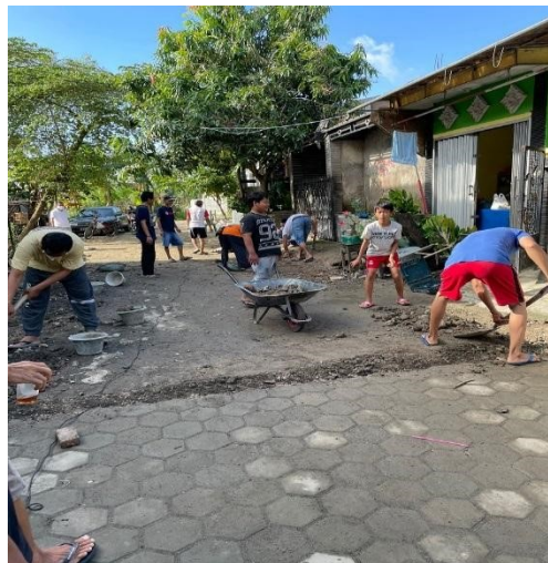
Gambar 6. Kerja Bakti Warga RT.013 RW.003 Perbaikan Jalan Rusak
