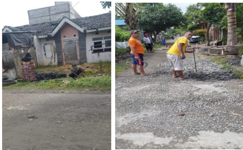
Gambar 5. Proses Kerja Bakti RT.013 RW.003 membersihkan saluran
