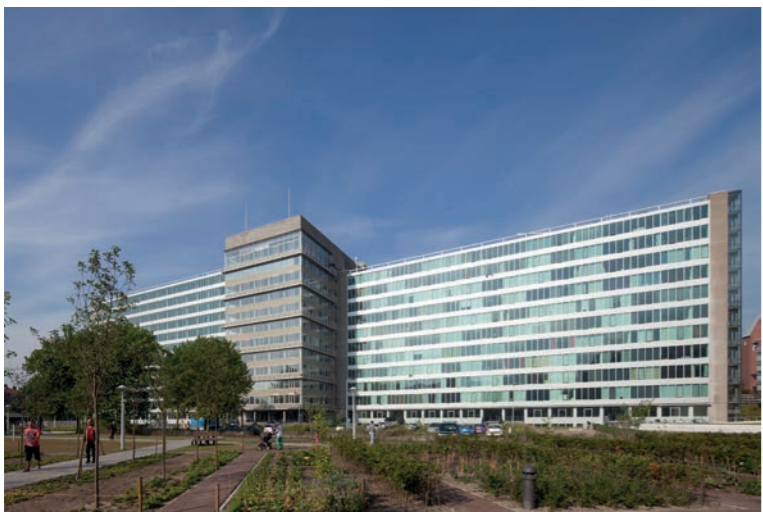
GAK gebouw, Amsterdam
