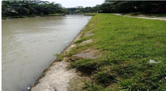
Gambar 2. Saluran Irigasi Primer BKr.0 (Sumber: Dokumentasi Lapangan)
