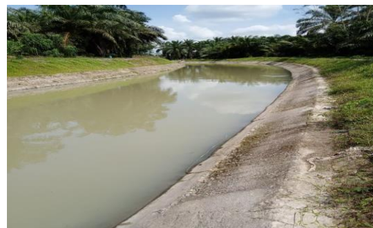
Gambar 4. Saluran Irigasi Primer BKr.1 (Sumber: Dokumentasi Lapangan)
