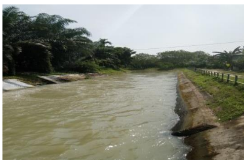
Gambar 3. Saluran Irigasi Primer BKr.1 (Sumber: Dokumentasi Lapangan)
