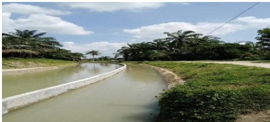
Gambar 5. Saluran Irigasi Primer BKr.2 (Sumber: Dokumentasi Lapangan)
