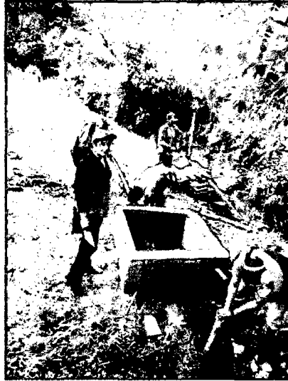
Fotografía 2. Tanque de alimentación de concreto de 1 m 3 .
