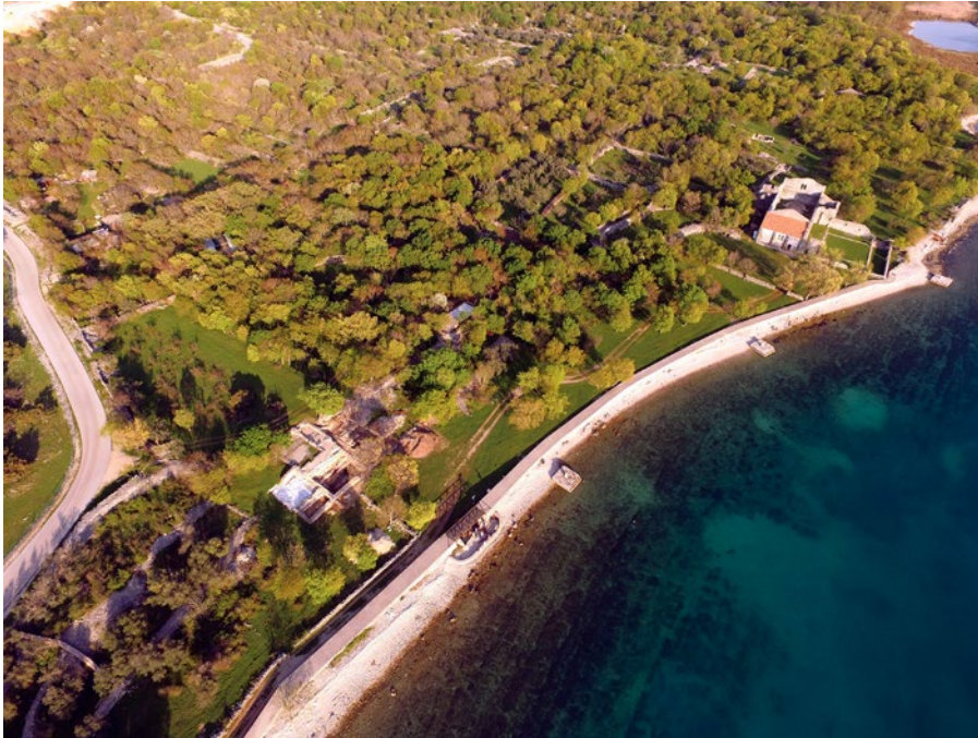
Sl. 2 Zračna snimka "crkvenog sklopa" na Mirinama (lokalitet Fulfinum – Mirine, Omišalj, otok Krk) (slikao Kaducej d. o. o. u okviru sustavnih istraživanja pod vodstvom M. Čaušević-Bully i S. Bully)
