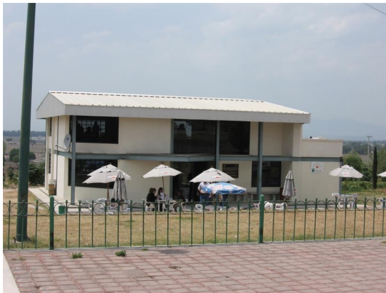
Instalaciones actuales de la cafetería del Centro Universitario UAEM Zumpango (Gonzalo Alejandro Ramos, 2015. Acervo de Gonzalo Alejandro Ramos).
