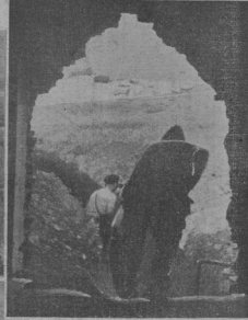
Progression, maison par maison, à travers les murs éventrés
