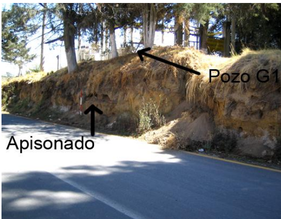
Foto 3. Vista general del apisonado.
