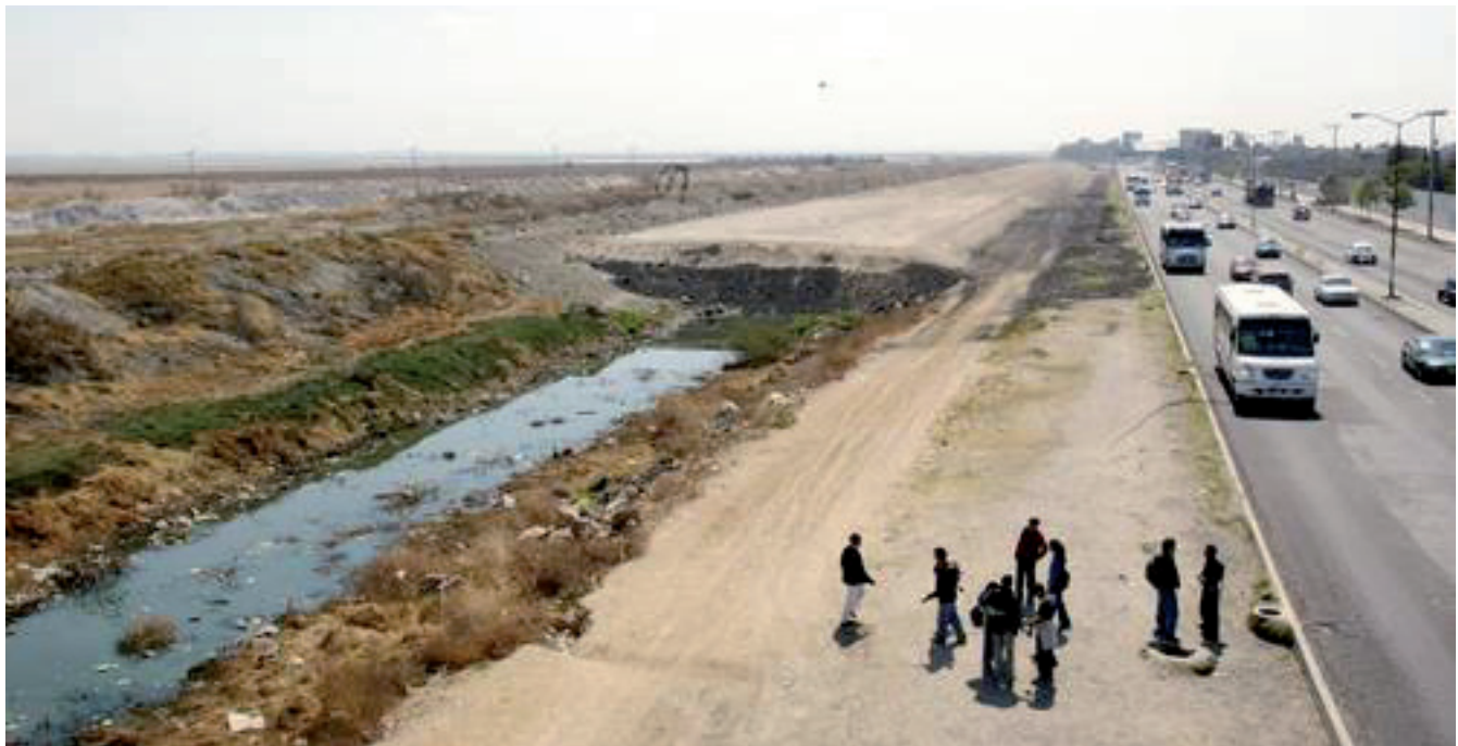
Canalización de escurrimiento de agua en paralelo al desarrollo de la vialidad, próximo a la Ciudad de México. Agentes sociales conociendo el proyecto.
