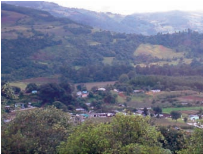
Construcción de viviendas en la dirección de la unidad deportiva, ubicada aproximadamente a 500 m. del área urbana consolidada. Santa Mónica.
