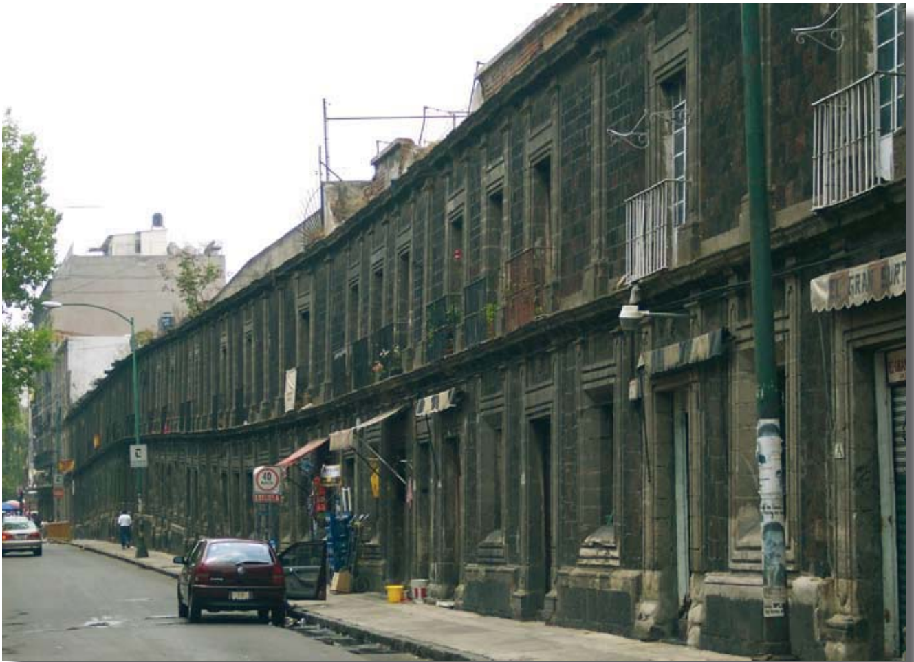
Hundimiento de la Ciudad de México como resultado de la construcción de edificios y estructuras arquitectónicas sobre lecho de suelos paleolacustres.
