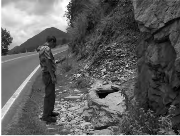
Esteban Valencia García, Auxiliar de la 3ª Regiduría, frente a la perforación de Ojo de Agua (galería filtrante), Acambay.
