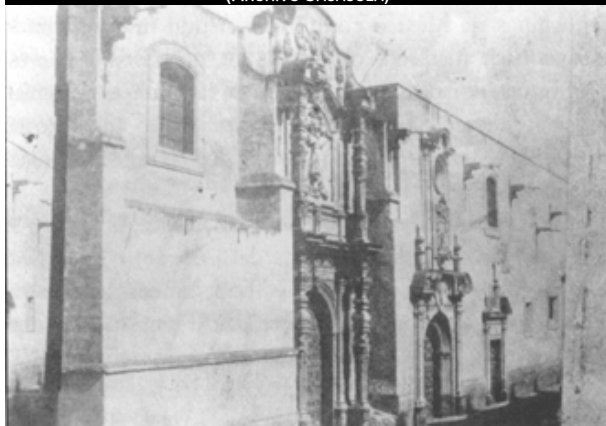
IGLESIA Y CONVENTO DE CAPUCHINAS ANTES DE SU DESTRUCCIÓN EN 1861 (ARCHIVO CASASOLA)
