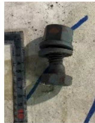
図 3.2.12 実験のボルトの変形
