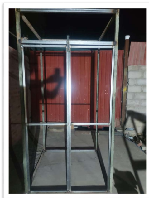
Fig. 37 Estructura de Cabina Antiruido N 2
