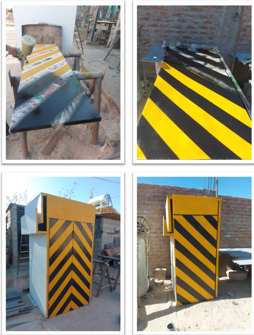
Fig. 40 Pintado de Cabinas Antiruido
