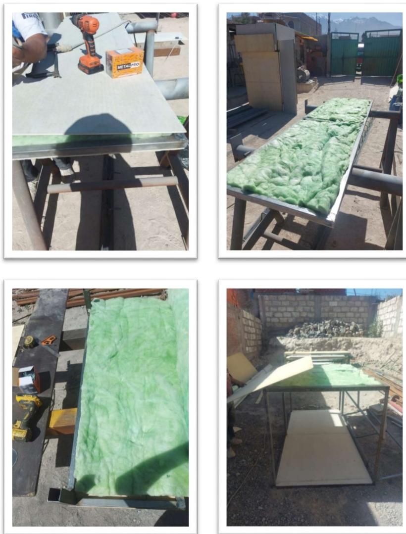
Fig. 38 Instalación de Placa de Fibrocemento y Lana de Vidrio
