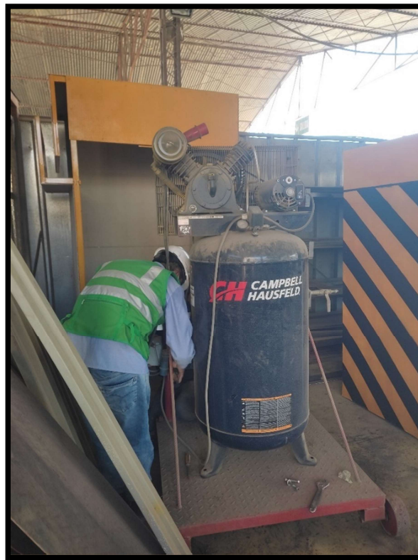
Fig. 41 Instalación de cabinas antiruido
