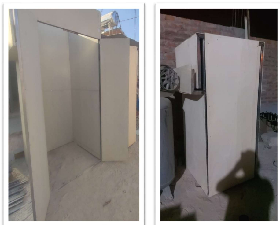
Fig. 39 Instalación de placas de triplay (cobertura exterior)
