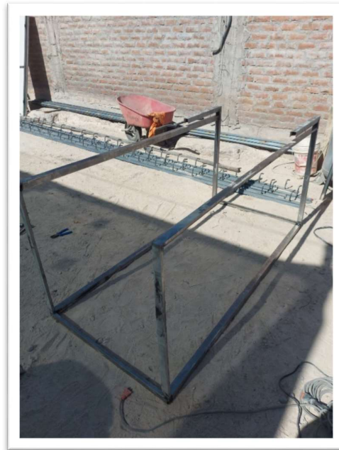
Fig. 36 Estructura de Cabina Antiruido N 1
