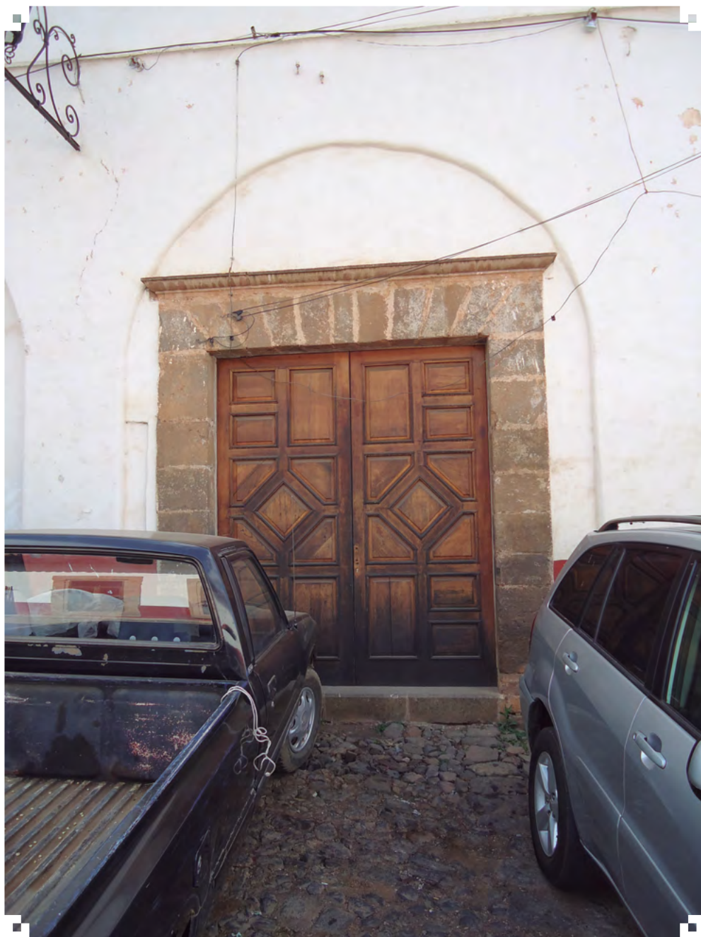
Imagen 30. Entrada al Colegio de San Ignacio de Loyola desde la Calle de las Alcantarillas.
