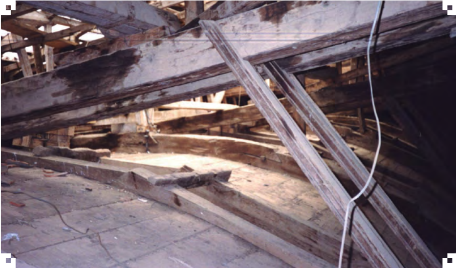
Imagen 24. Estructura de la bóveda de madera del Templo de San Ignacio. Fotografía: Archivo de la arquitecta Gloria Álvarez, 1990-1992
