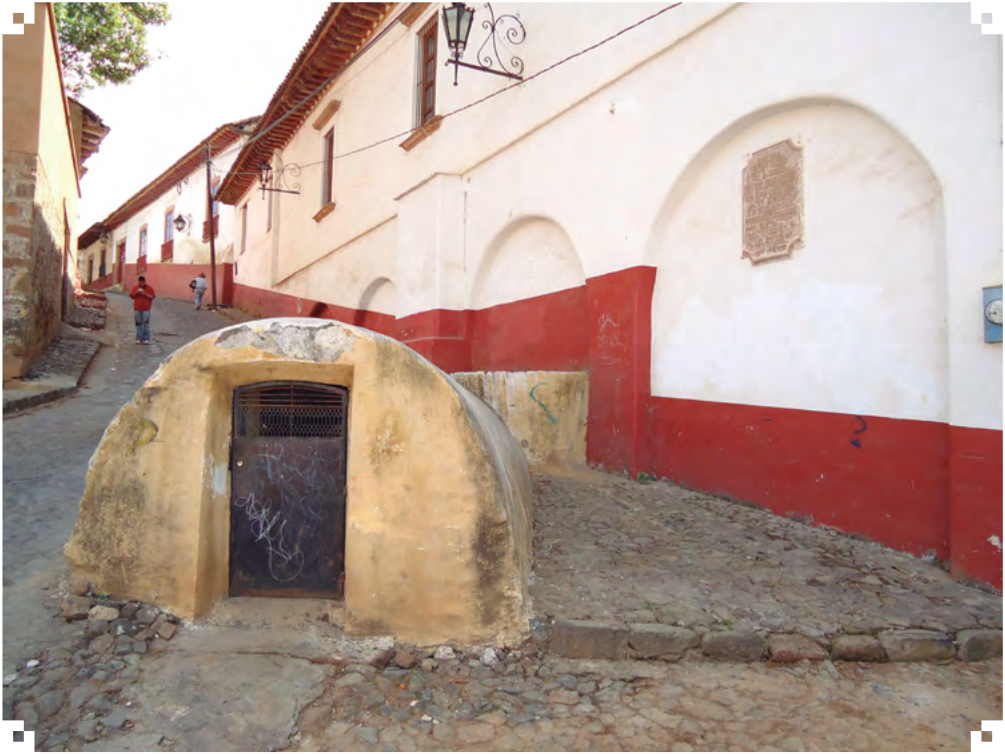
Imagen 31. Desnivel de la Calle de las Alcantarillas. Fotografía: Carlos Alfonso Ledesma Ibarra, 2010
