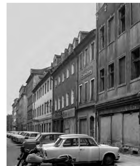
Die Heinrichstraße in den 1980er-Jahren
