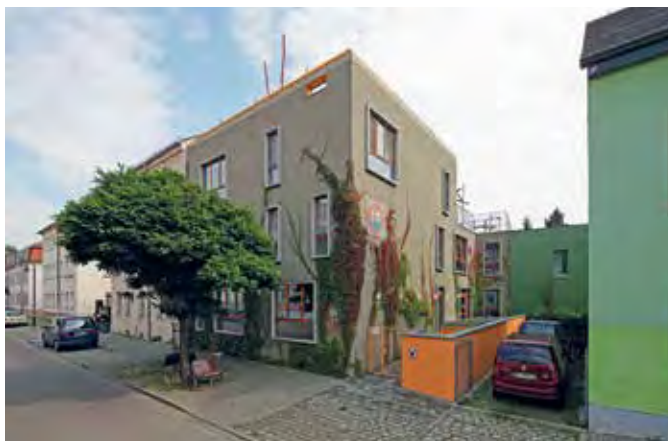
... mittendrin, die Kita »Leuchtturm«. Aufgrund der begrenzten Freiflächen wurden das Dach des Haupt- und Nebengebäudes als Dachspielfläche konzipiert.
