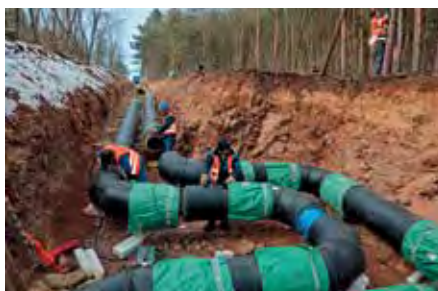
Verlegearbeiten am Steilstück »Heide« vor Infinion – Dehnungsbögen und effiziente Wärmedämmung
