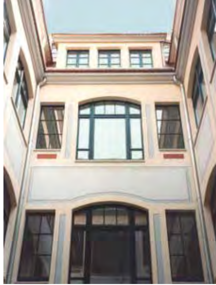
Königsstraße 8 nach der Sanierung
