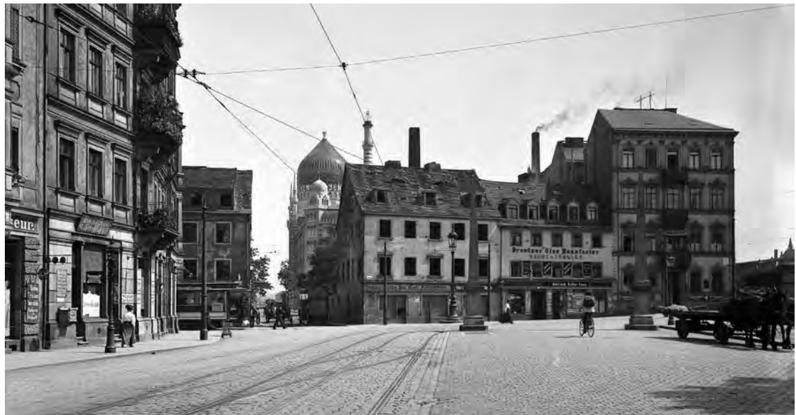
Weißeritzstraße 12 und Friedrichstraße 4 vor dem Abbruch für den Bau des Kühlhauses am 18. Juni 1910. Im Hintergrund die Zigarettenfabrik Yenidze.
