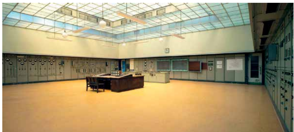
Die ehemalige Schaltzentrale
