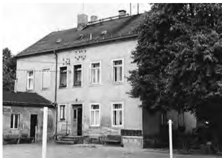
Ehemaliges Wohnhaus vor der Sanierung, 1996
