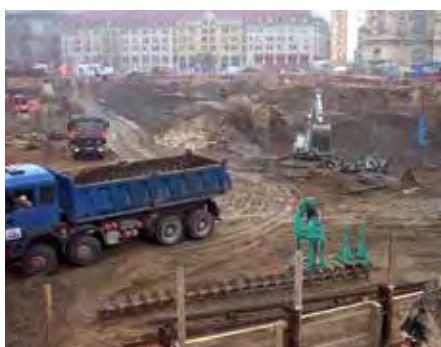
Der Bau der Tiefgarage unter dem Neumarkt
