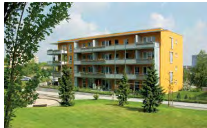
Geschossreduzierung und Rückbau in der Kräutersiedlung
