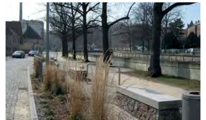
Die ausgebaute Hofmühlenstraße
