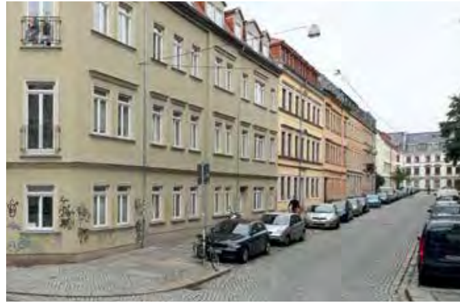
Die Talstraße nach erfolgter Sanierung der Gebäude, Straße und Gehwege
