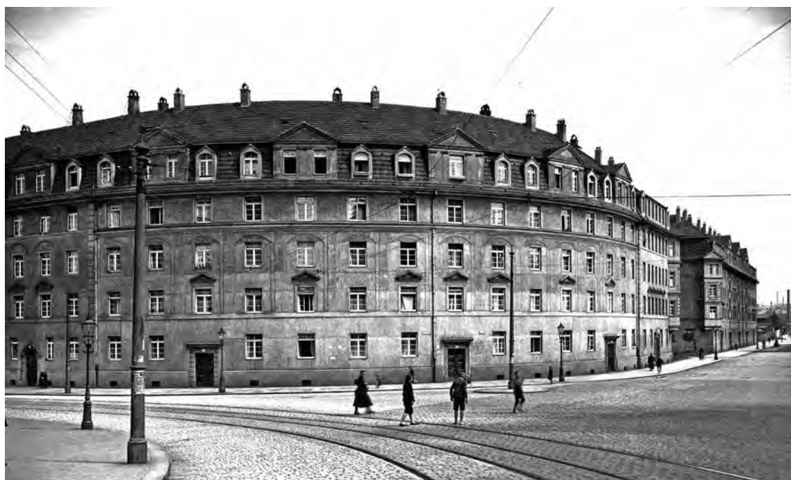
Wohnbebauung auf dem Gebiet des ehemaligen Floßhofes, um 1910
