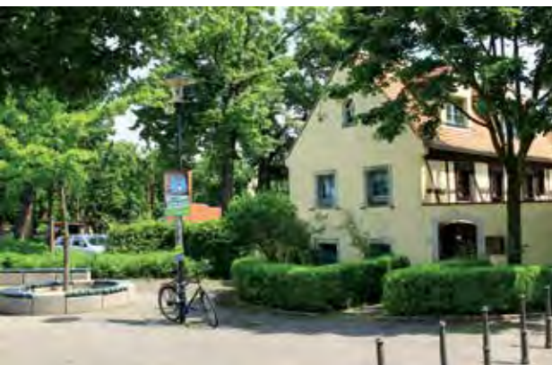
Blick vom Festplatz auf das sanierte Wohnhaus Talstraße 3
