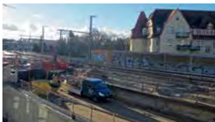
Neubau S-Bahn-Station am Bischofsplatz
