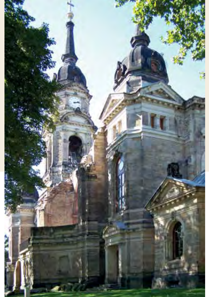
Dringend notwendige Sicherungsmaßnahmen an Fensterwänden, Bodenfangsteinen, Dach, Decken in der Sakristei und dem Altarraum der Trinitatiskirche waren wertvolle Hilfe für die Arbeit des Jugend- und Wohngebietstreffs.
