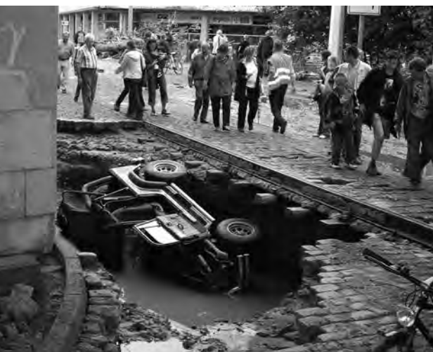
Hochwasserfolgen an der Nossener Brücke, 2002
