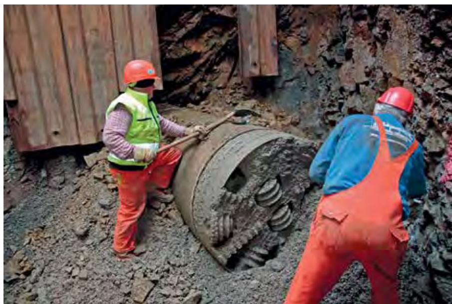
Der Bohrkopf und das mitgeführte Rohr in der Zielgrube der Durchörterung an der Karl-Marx-Straße in Klotzsche
