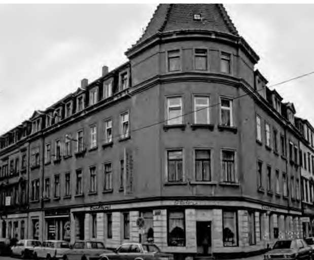
Oschatzer Straße 13 vor der Sanierung, 1994
