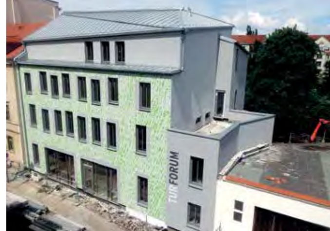
Mit EFRE-Mitteln neugebaut: Soziokulturelles Zentrum an der Friedrichstraße
