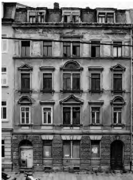
Fichtenstraße 17, Fassade vor der Sanierung, 2002
