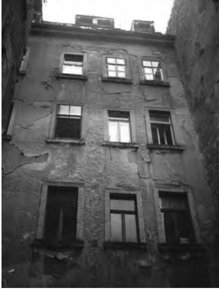
Königsstraße 8 vor der Sanierung
