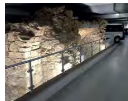
Bei den archäologischen Grabungen freigelegte erhaltenswerte Gewölbe wurden sichtbar in die Tiefgarage integriert
