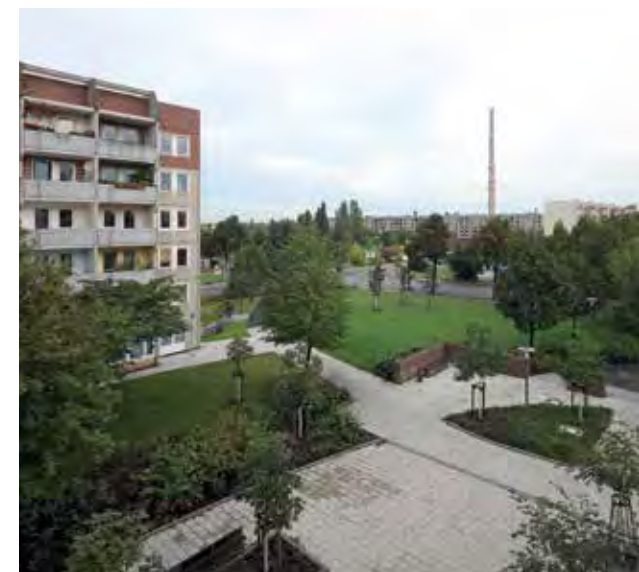
Stadtplatz Walter-Arnold-Straße – Eingang ins Wohngebiet Am Koitschgraben gefördert mit rund 780.000 Euro
