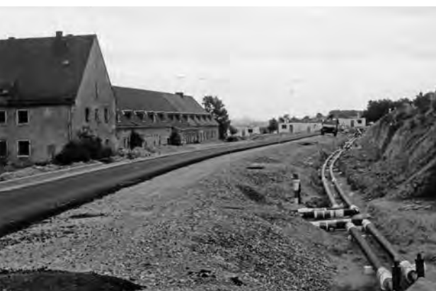
Straßenbau an der Kaserne Herbert-Collum-Straße, 1998
