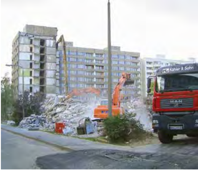
Rückbau Elsterwerdaer Straße 1-7
