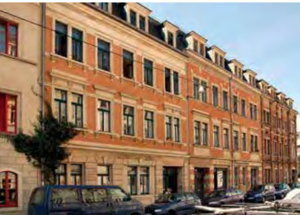
Das Wohngebäude Sebnitzer Straße 28 nach der Sanierung
