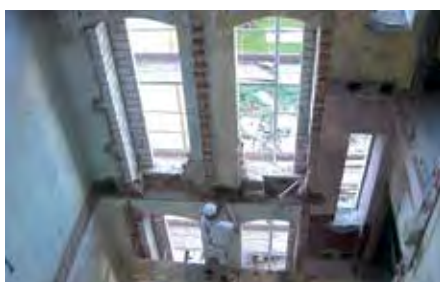
Fichtenstraße 17, während der Bauphase
