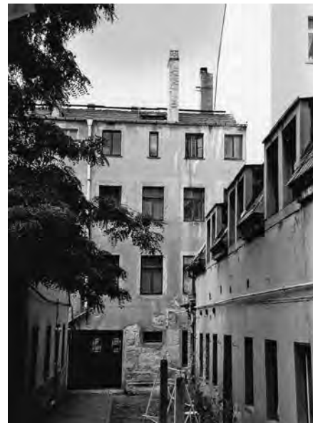
Innenhof in der Rudolf-Leonhard-Straße 38, 2004
