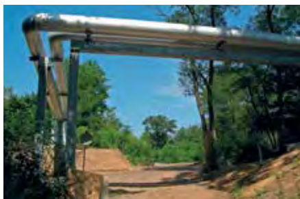
Rohrbrücke am Diebsteig in der Dresdener Heide
