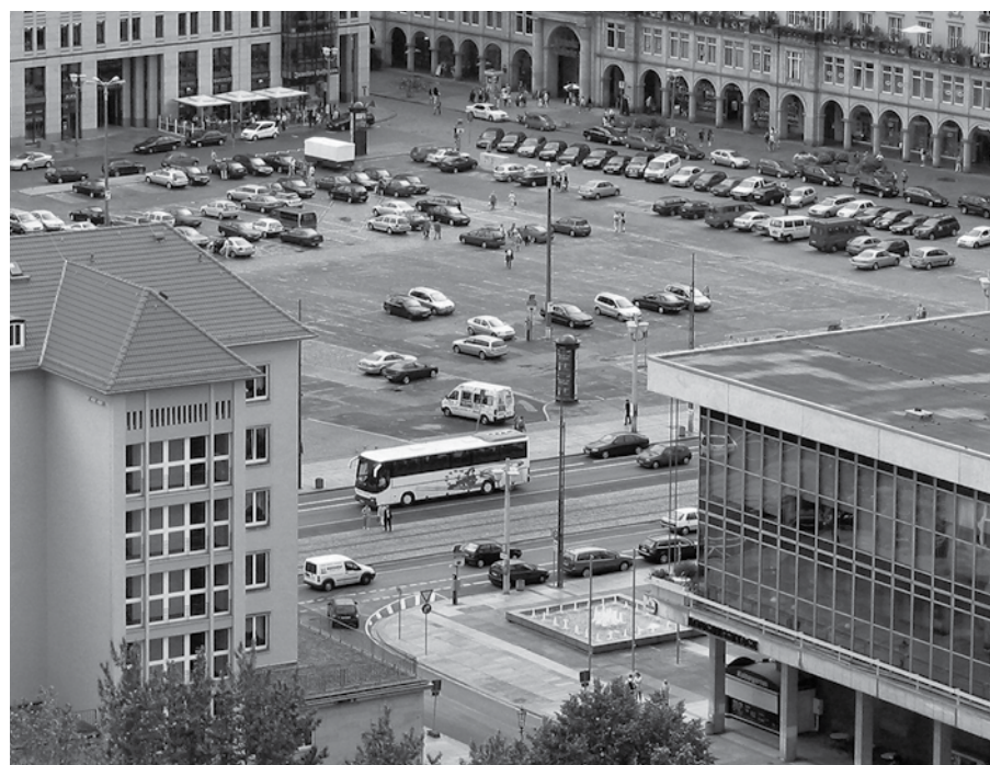
Der Altmarkt vor der Sanierung
