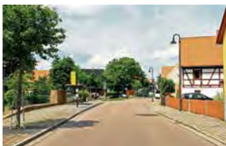
Die grundhaft sanierte Hauptstraße
