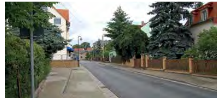
Die sanierte Bruhmstraße, 2015
