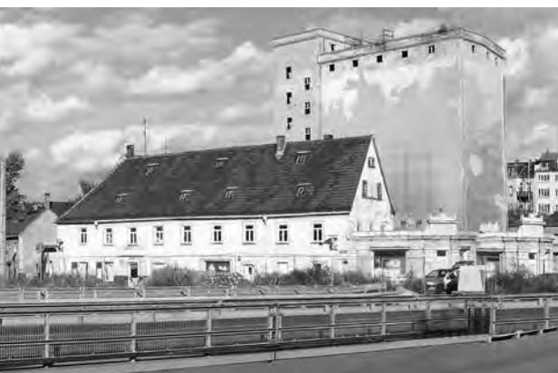
Der 30 Meter hohe Getreidespeicher vor seinem Abriss
