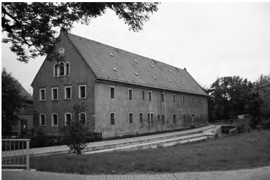
Palitzschhof vor der Sanierung
