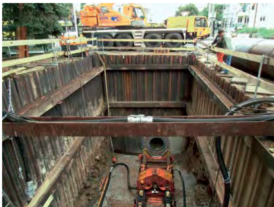
Startgrube der Durchörterung – »Durchörterung« bezeichnet das grabenlose Verlegen von Rohren oder Kabeln im Erdreich
