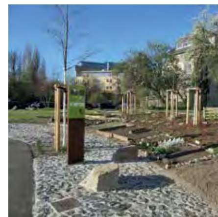
Freiflächengestaltung auf der Columbusstraße kurz vor der Fertigstellung im April 2015
