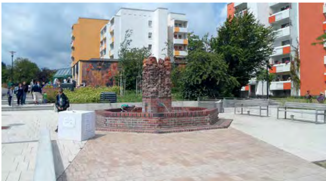
Der im Jahr 2012 sanierte Märchenbrunnen – Auftakt zur Höhenpromenade
