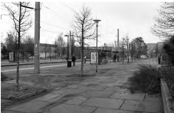
Amalie-Dietrich-Platz – der ehemalige Platz der Bauarbeiter vor der Sanierung
