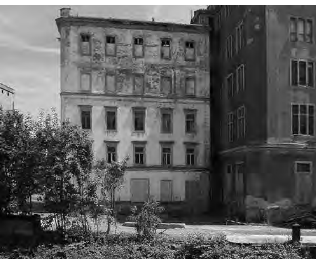
Bienertmühle, Kopfbau vor der Sanierung
