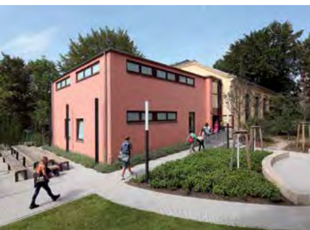
Die vollständig sanierte Turnhalle und ein attraktiv gestalteter Schulhof
