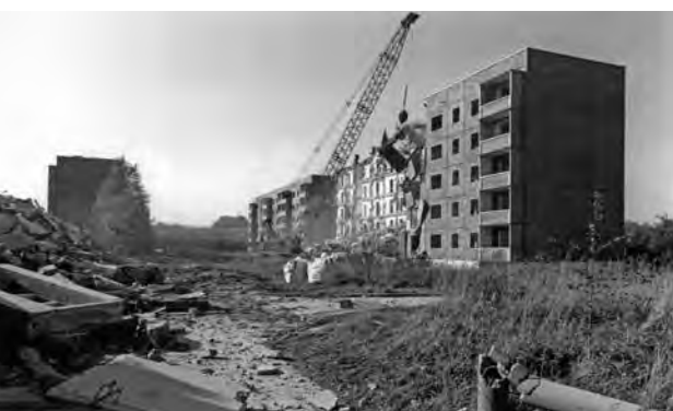
Abriss der Plattenbauten, 1995
