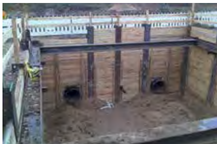
Grube am Diebsteig mit den Rohren für Vor- und Rücklauf
