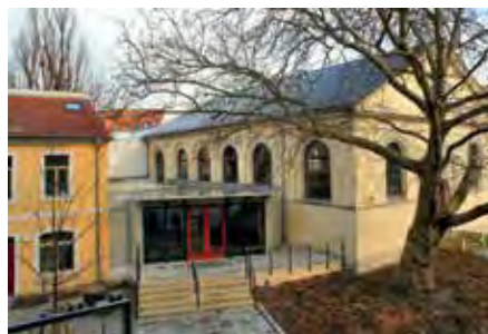
... nach Sanierung Aula des Konservatoriums
