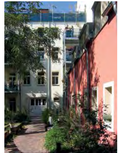
Der Innenhof nach Abbruch des Seitengebäudes
