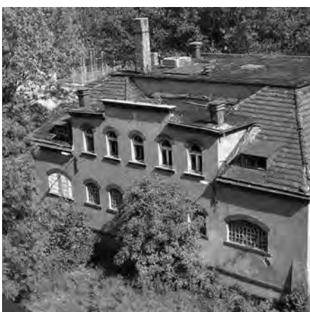
Volksbad Löbtau, ehemaliges Reinigungsbad, 1994 stillgelegt
