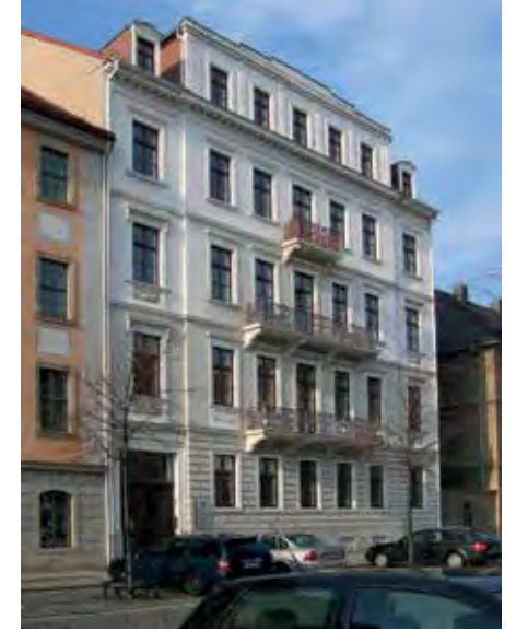
Königsstraße 19 nach der Sanierung, 2008
