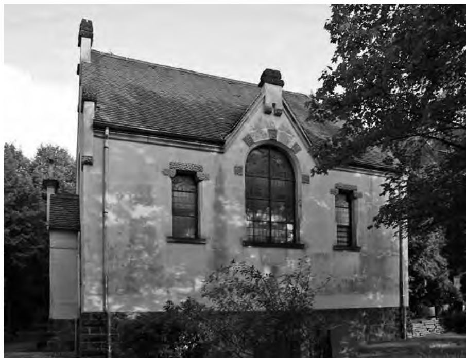
Die Friedhofskapelle vor seiner denkmalgerechten Sanierung, 2012
