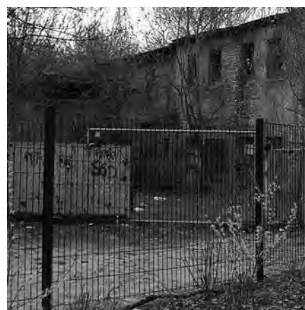
Grundstück mit ehemaliger Maschinen-Fabrik vor dem Abbruch
