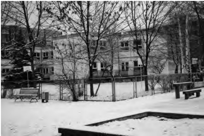
Der ehemalige Plattenbau-Kindergarten vor der Sanierung
