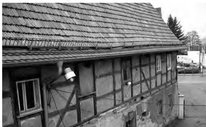
Talstraße 5 vor der Sanierung und dem Umbau zum Heimathaus
