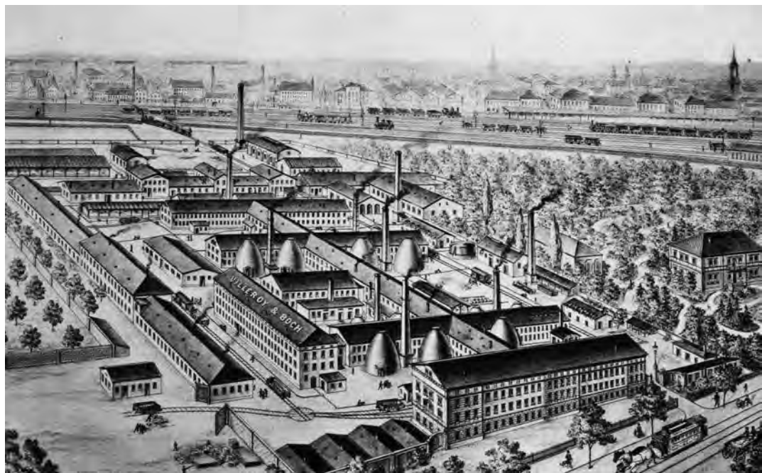
Ansicht der Steingutfabrik von Villeroy & Boch, um 1890 (Lithografie)
