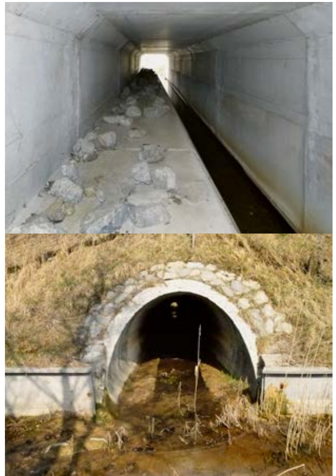
Abb. 57: Gewässerunterführungen mit Randstreifen
