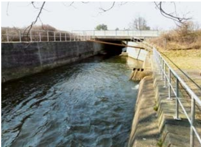
Abb. 33: Gewässerunterführung (> 2 m) ohne Randstreifen mit Wehr im Umfeld an der A13
