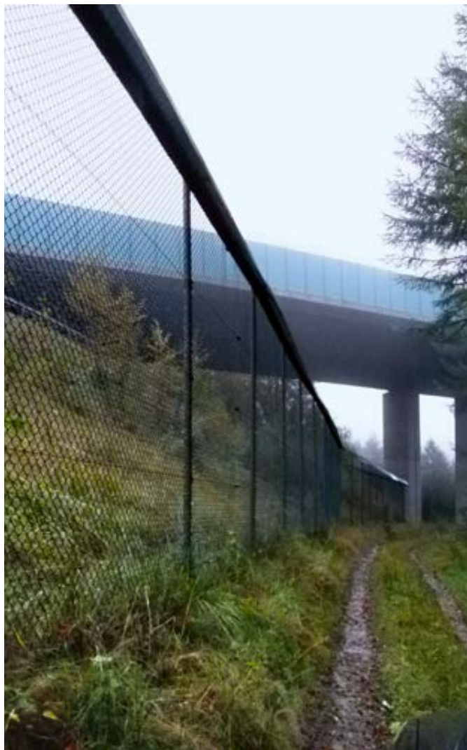
Abb. 60: Wildkatzen- und Luchssicherer Zaun an der A17 nahe der tschechischen Grenze
