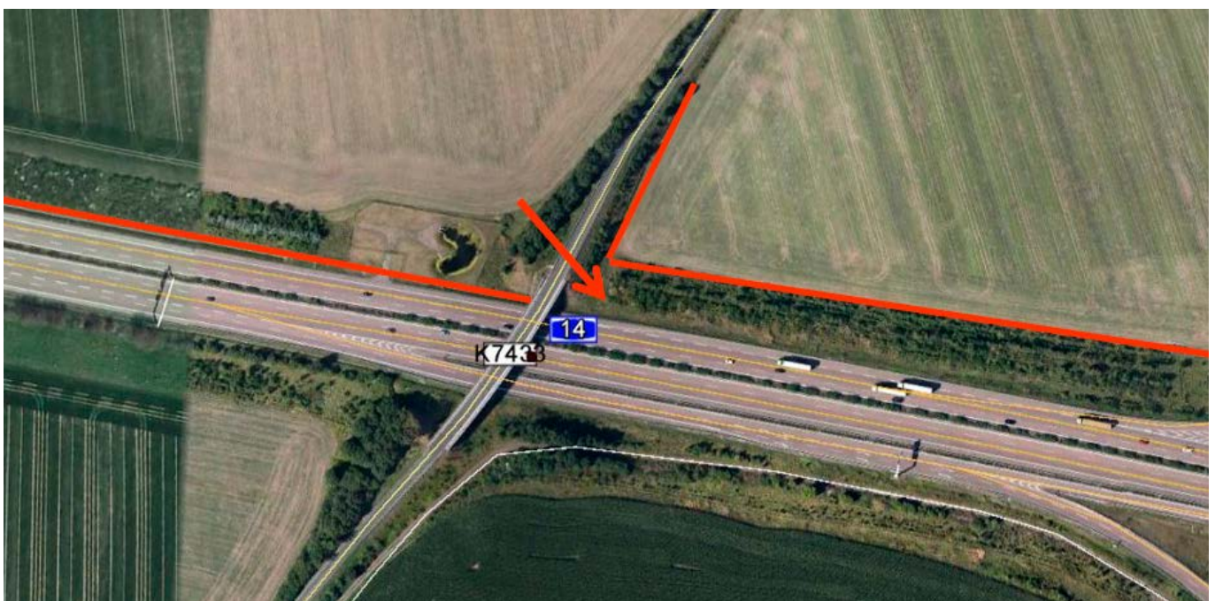
Abb. 53: Ungleiche Zauanbindung (rote Linie) an einer Überführung an der A14 mit Zugangsmöglichkeit (Pfeil) in den gezäunten Bereich
