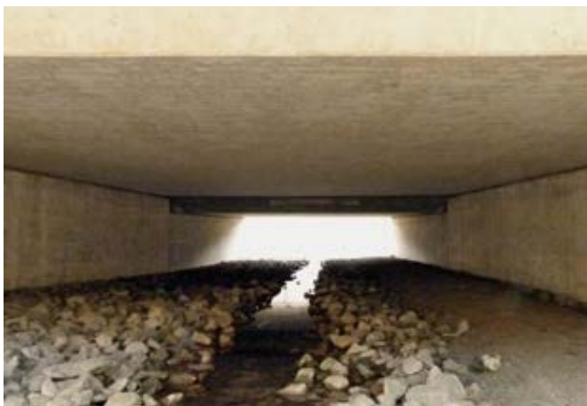
Abb. 51: Rohbodenaufschüttung auf grobem Schotter in einer Fließgewässerunterführung an der A40st
