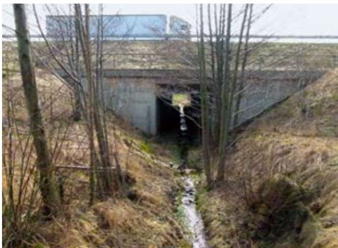
Abb. 29: Gewässerunterführung (> 2 m) mit Randstreifen im A40st
