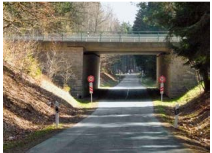
Abb. 27: Straßenunterführung im Wald an der A72
