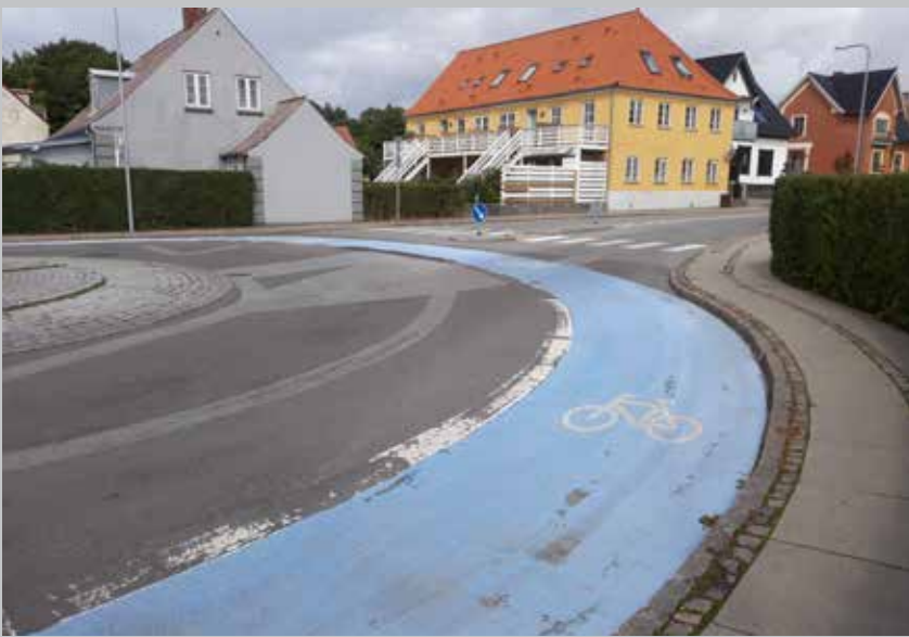
I denne rundkørsel er problemet med cirkulerende cyklister søgt reduceret med en farvet cykelbane [foto: Ludvigsen].
