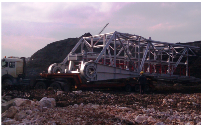
Slika 6. Prevoz nove konstrukcije ka radilištu
