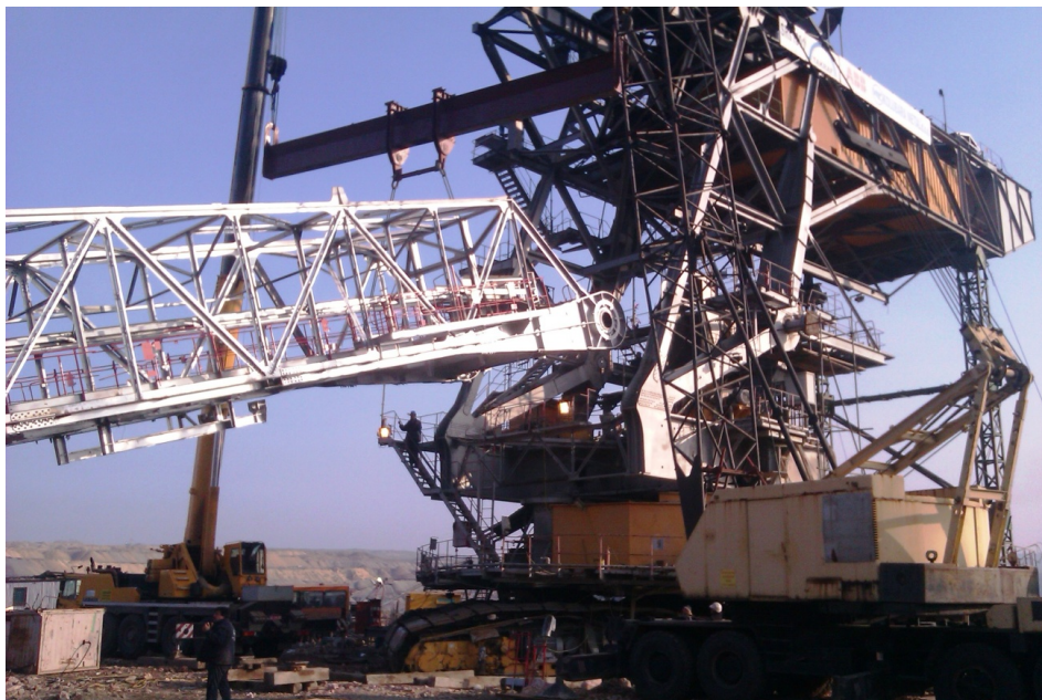
Slike 10,11,12,13. Montaža konstrukcije strele radnog točka
