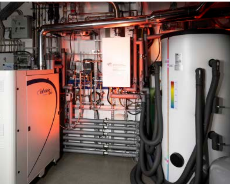
Fürs Heizen von Gebäuden erforscht das DLR-Institut für Vernetzte Energiesysteme die „H2-ready-Technologie“. Langfristig könnte so auch Wasserstoff aus erneuerbaren Quellen direkt in Brennstoffzellen-Blockheizkraftwerken zum Einsatz kommen.
