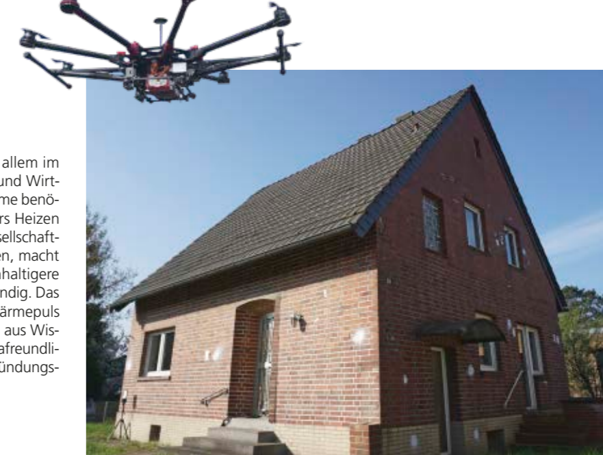
Eine kleine Drohne erfasst Gebäude hinsichtlich ihrer geometrischen, bauphysikalischen, energetischen und funktionalen Eigenschaften.
