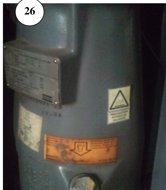
Fig. 11 Compresor con señalamiento
