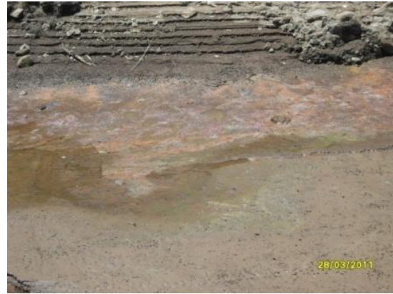
Figura 7. Suelo con coloraciones ocres y rosadas en la entrada de la presa Tecualoyan.
