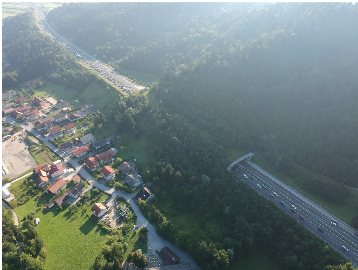
Slika 3.1: prikaz začetka prometnega zastoja pred predorom Strmec v času sanacije predora Golovec
