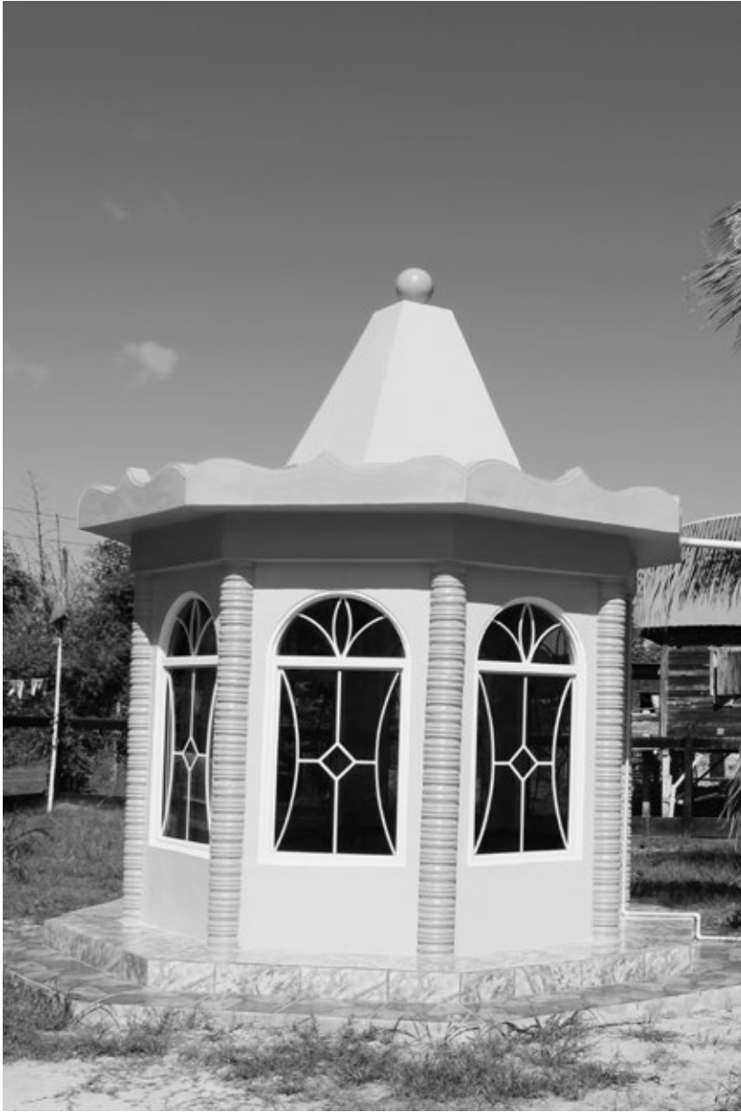
1 Das neu errichtete Gebäude am Eingang des Koiloo von Bedford, Guyana, September 2017 (siehe Taf. 11a)
