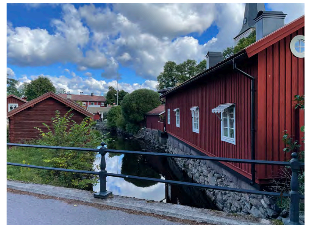
Figur 14: Vy över Norbergsån med byggnader från 1800-tal och privata trädgårdar. Detta är en del av riksintresset för kulturmiljövård med utblick norrut från Fagerstabron.
