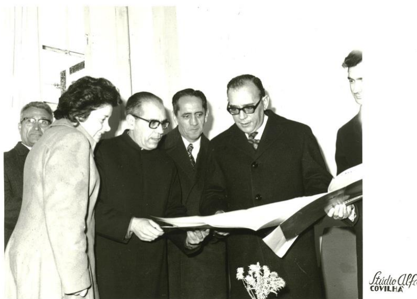
Figura 59 - Ângelo Fonseca (à esquerda na foto) no planeamento da construção do novo Abrigo de São José Fonte: Coleção pessoal do Abrigo de São José
