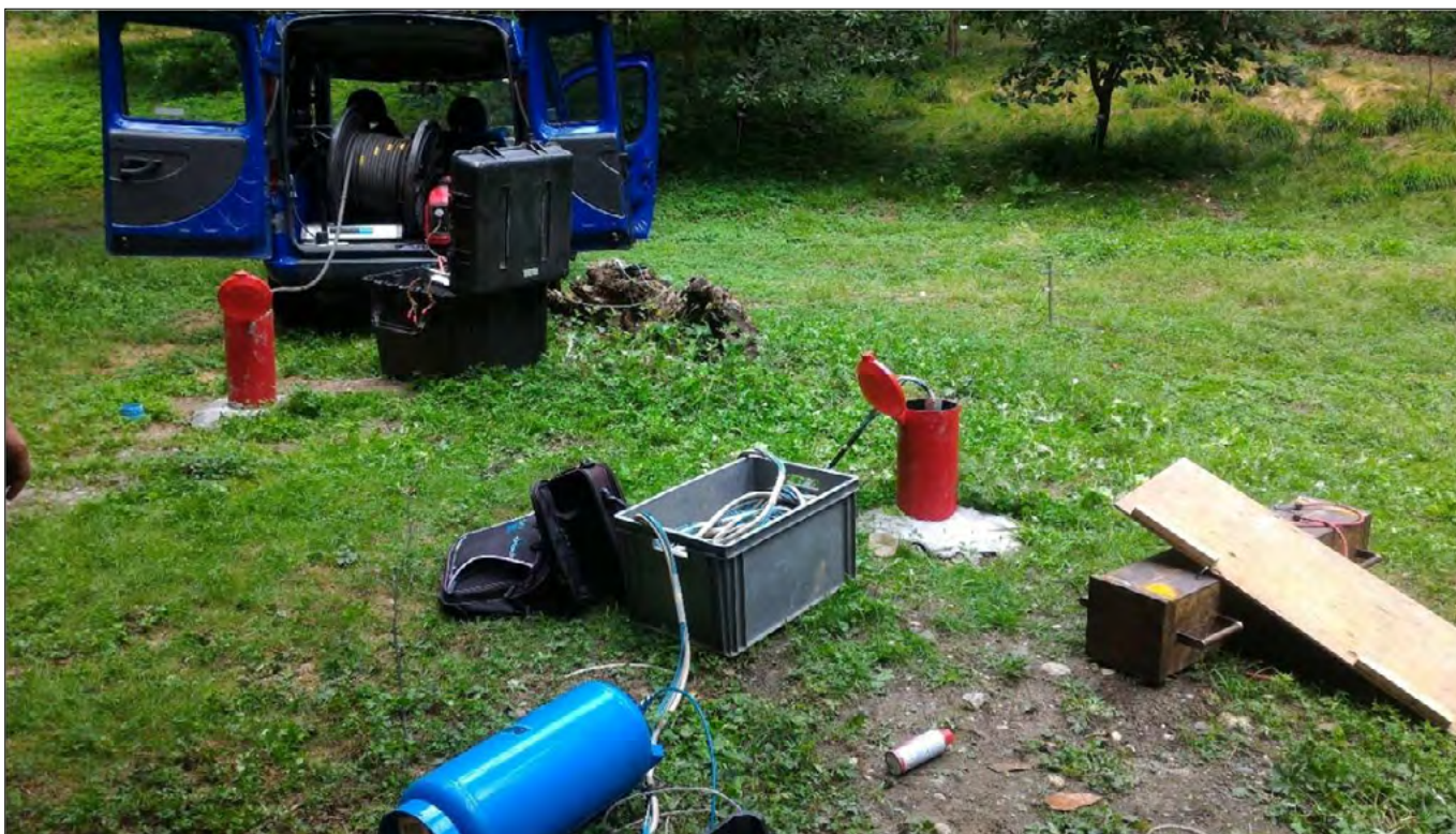
FIGURA 8 - Esecuzione della prova Crosshole. Il sistema energizzante è stato inserito all'interno del sondaggio S1, mentre il sistema ricevente all'interno del sondaggio S2. Tramite gas in pressione contenuto all'interno della bombola, visibile in primo piano, viene mantenuta l'aderenza ai tubi in PVC dell'insieme cavo-ricevitori all'altezza voluta.
