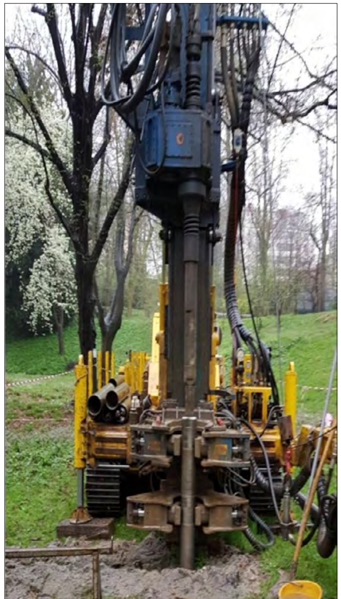
FIGURA 3 – Perforazione a carotaggio continuo per l’installazione del primo piezometro.
