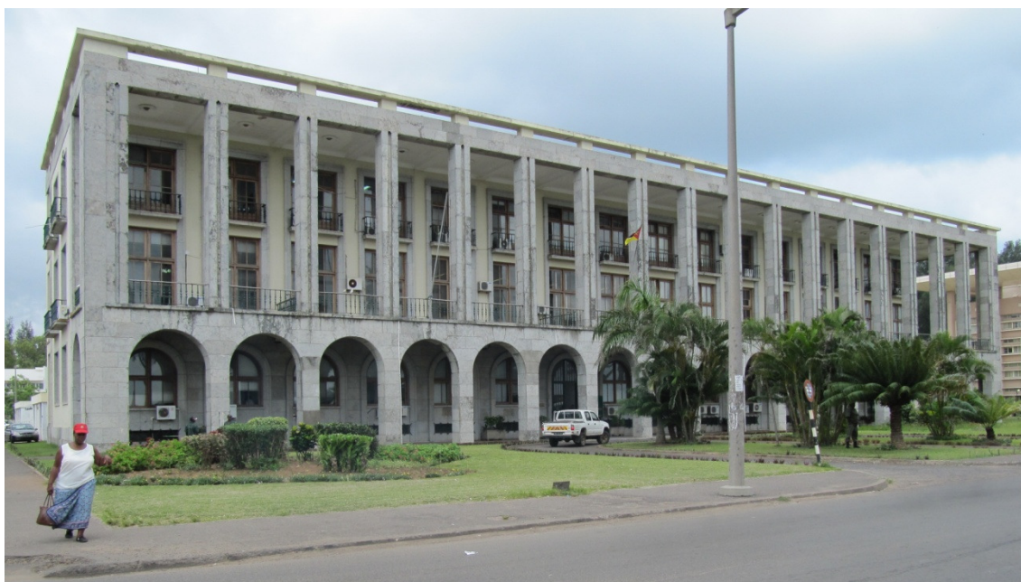
Fig. 10 - Antigo edifício do Centro Cívico, Maputo, João Aguiar?/GUU, s.d. [Foto: Paulo Tormenta Pinto, 2010]
