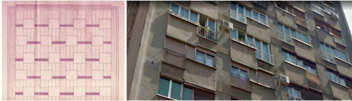
Слика 60. Детаљи фасадних елемената југозападне фасаде - пројектовано стање (слика лево) и постојеће стање (слика десно)
