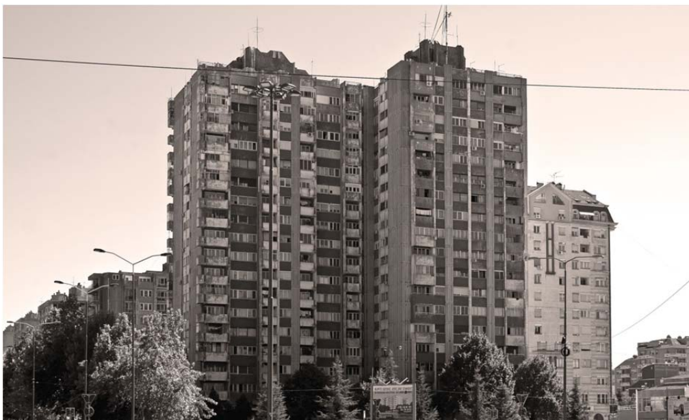
Слика 170. Садашњи изглед објеката посматрано са угла булевара и Улице В. Мишића Извор: Монографија и изложба „50 објеката 1970-1990.„ ДАН Ниша, 2012, стр. 29
