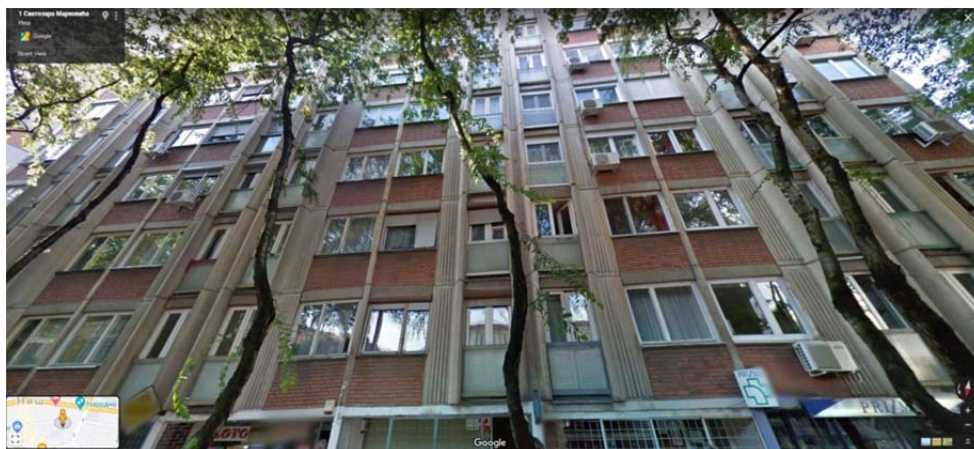
Слика 131. Садашњи изглед северне фасаде објекта на Синђелићевом тргу Извор: Google street view
