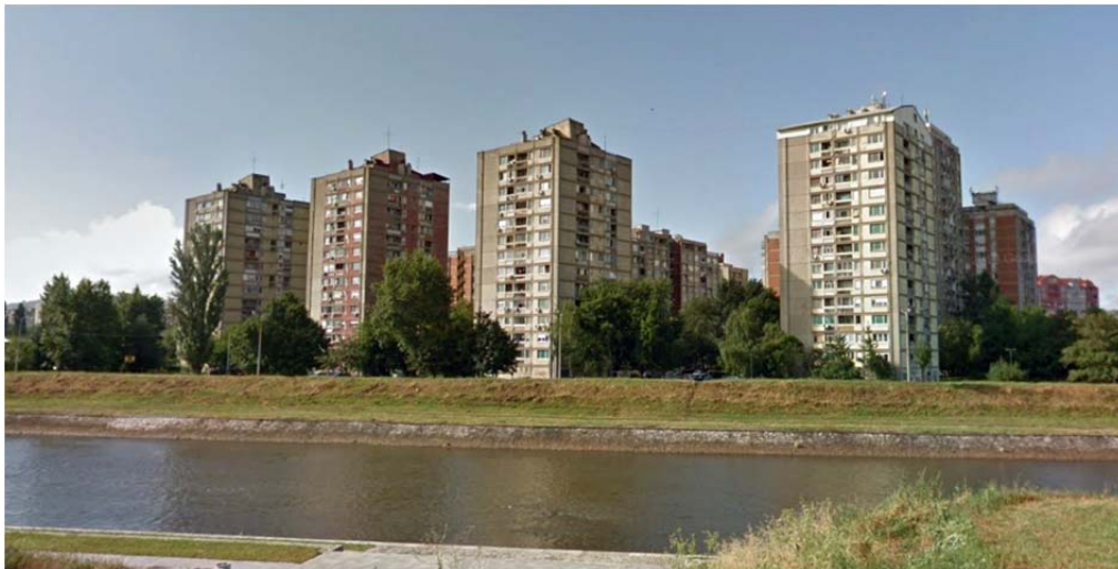
Слика 183. Садашњи изглед објеката посматрано из правца реке Нишаве са северне стране Извор: Google street view
