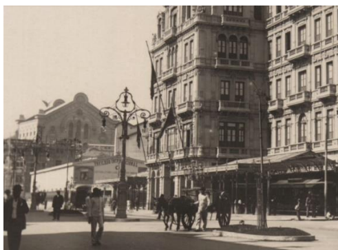
Fig. 1 - O Pavilhão Internacional na Avenida Central, ao lado do Hotel Avenida. Detalhe de estereoscopia do acervo do Arquivo Nacional (BR_RJANRIO_O2_0_FOT_0520_m0004). Autor desconhecido. c.1908.
