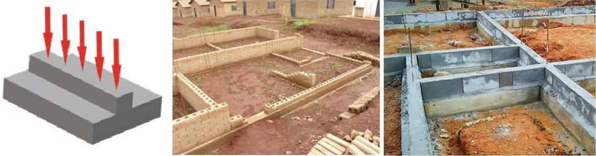
Figura 3.3- Sapatas corrida. Fonte: <https://celere-ce.com.br/construcao-civil/fundacoes-de-obras/>.
