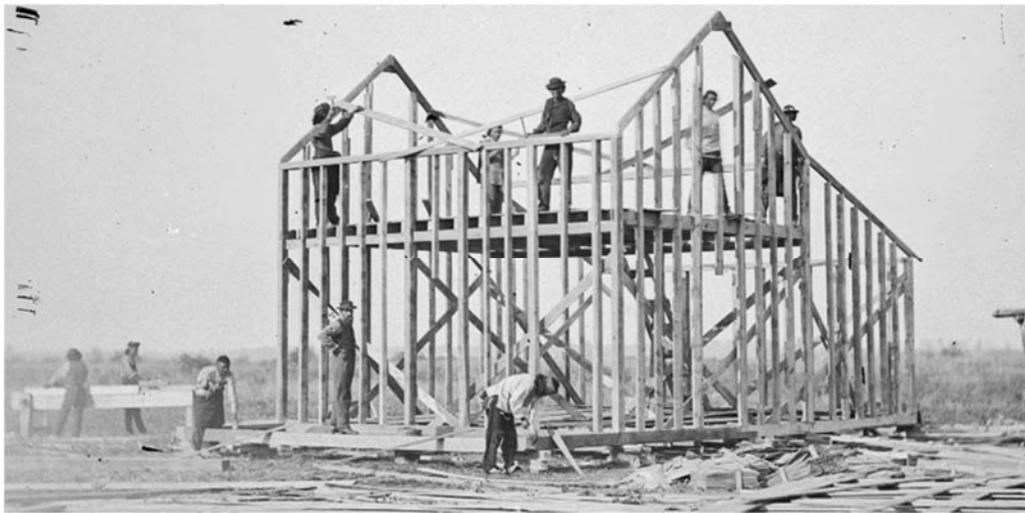
Figura 2.1- – Estrutura em Wood Frame Fonte <http://steelframebrasil.com.br/quando-o-steel-frame-chegou-no-brasil-e-sua-historia/>.
