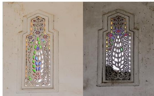
(صورة ٩-أ) الشبائيك الجصي في الناحية الأيمن وتتضح مخلفات وفضلات الطيور بالجدران حول الشبائيك. (صورة ٩-ب) الشبائيك الجصي في الناحية الأيسر وتتضح أعشاش داخل الشبائيك وفضلات الطيور حول الشبائيك.
