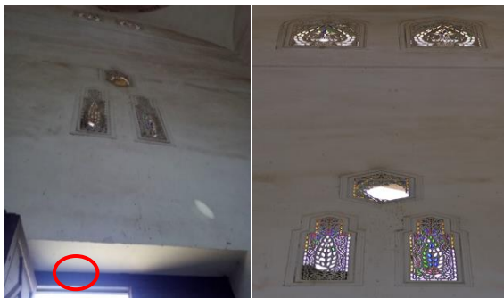
(صورة ١٠-أ) توضح القنديلية البسيطة أعلى الباب. وتراكم الأثرية لسنوات والتصاقها بالجدران والشبائيك. (صورة ١٠-ب) الشبائيك الجصية تعلوها قبة نصف دائرية. فقد نهائي لأجزاء من الجص والزجاج في الفتحة العلوية.
