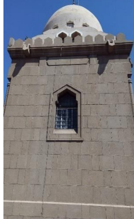
(صورة ٨-أ) توضح الشكل الخارجي للمقبرة من الجانب الأيسر من أعلى والمزاريب لتصريف المياه. (صورة ٨-ب) الجانب الأيمن والشباك الزجاجي مكسور منه أجزاء بما يسمح بدخول الأتربة والطيور إلى الداخل.
