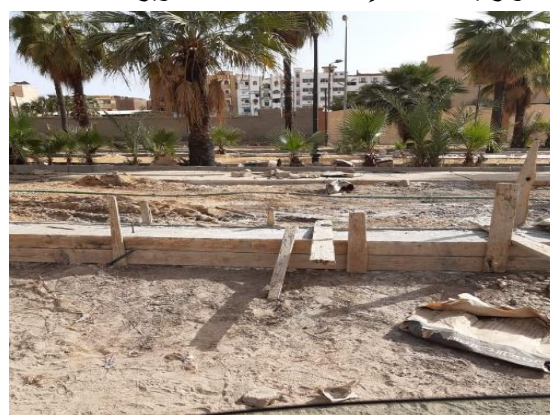
(صورة ٣٣) أثناء أعمال التطوير والترميم للمدخل وبناء الرصيف الجديد ذلك لتطوير محيط القبّة © تصوير الباحث.
