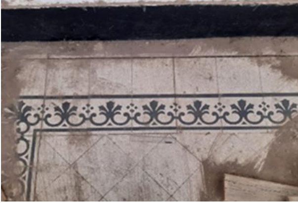
(صورة ٢٦) توضح البدء في تنظيف أرضية القبة وتظهر زخارف بلاطات القيشاني التي كانت مختفية تحت تراكم الأتربة والأخشاب ومخلفات البناء © تصوير الباحث.
