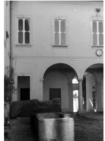
Fig. 36: Foto prospetto sud corte interna.
