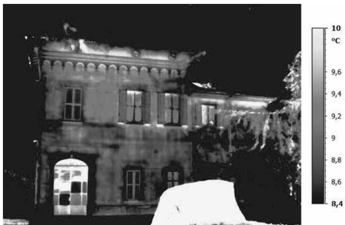
Fig. 31: Termogramma all'infrarosso termico - Prospetto nord torretta.
