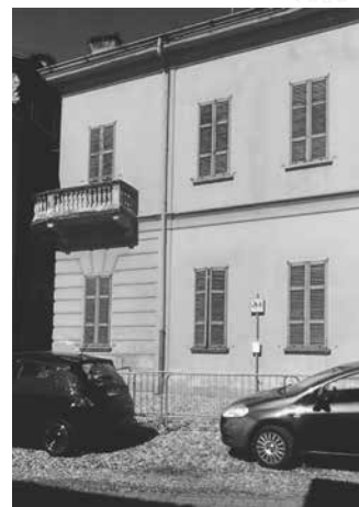
Fig. 30: Foto prospetto sud su via Foscolo.
