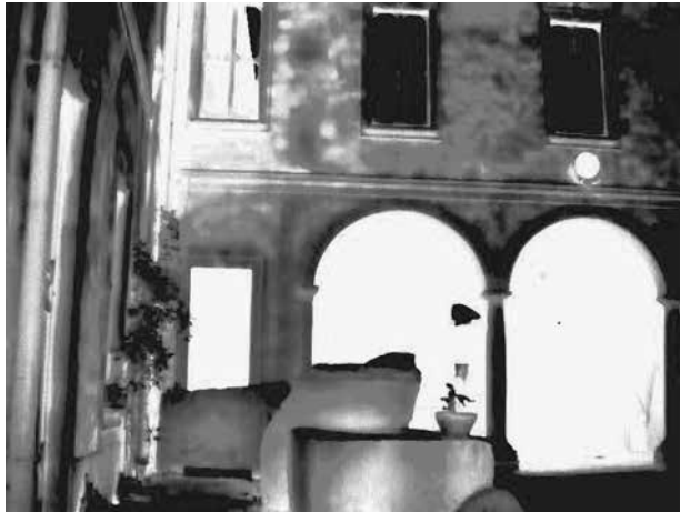
Fig. 35: Termogramma all'infrarosso termico - Prospetto sud corte interna.
