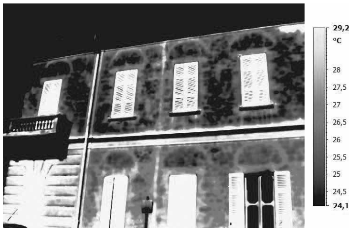
Fig. 29: Termogramma all'infrarosso termico - Prospetto sud su via Foscolo.
