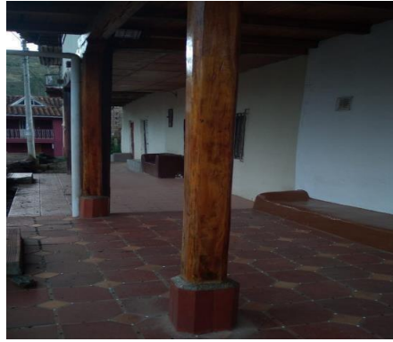
Fotografía 12: Columnas de las casas del centro histórico de Quingeo
