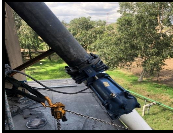
Figura 21. Guillotina neumática de descarga
