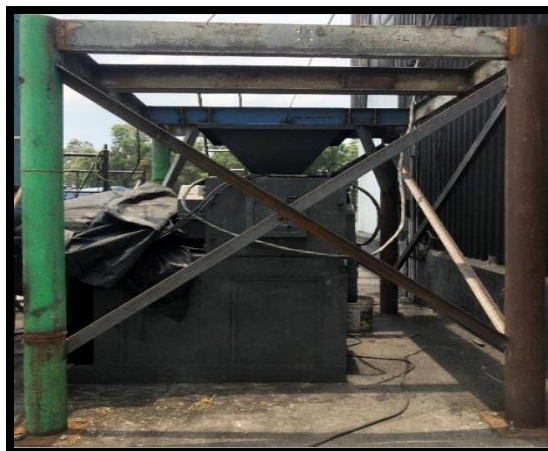
Figura 18. Montaje de vigas
