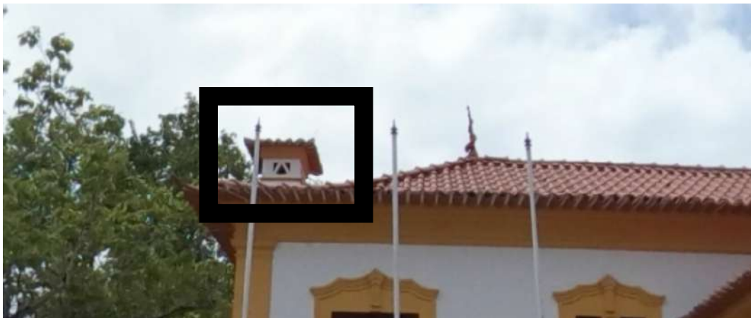
Figura 20 - Vista da chaminé da Casa de Chá através da Visita Virtual
