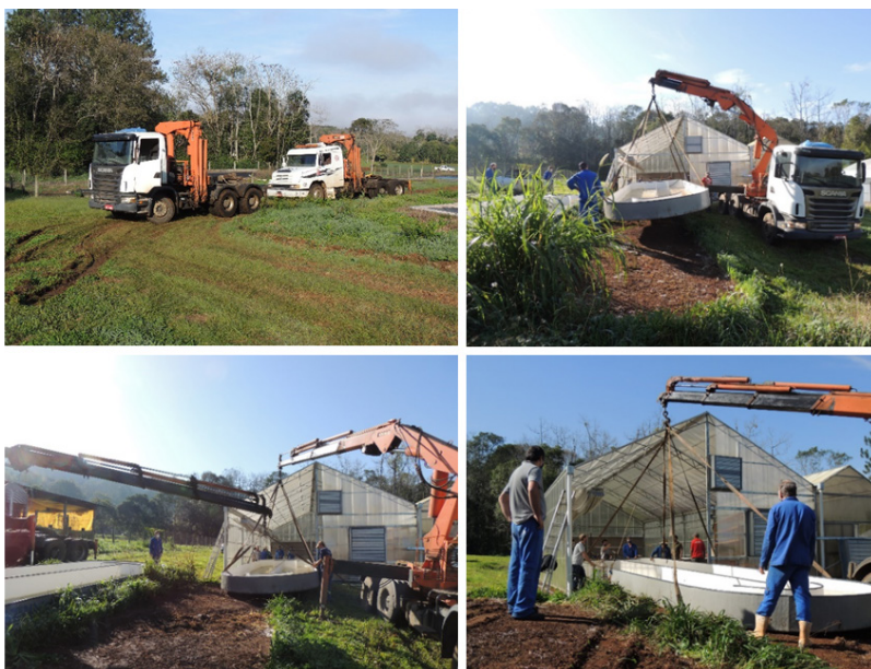
Figura 8. Instalação dos tanques de produção ( raceways ) dentro da casa de vegetação.
