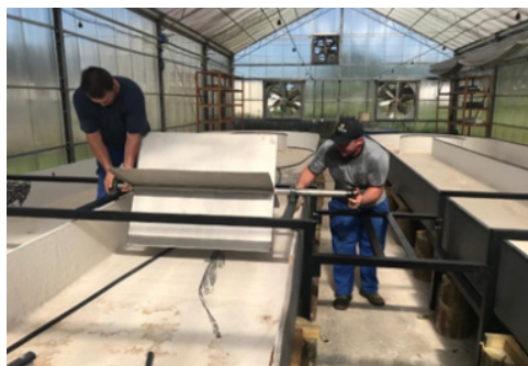
Figura 9. Instalação do eixo rotatório, pás e moto-reductor.
