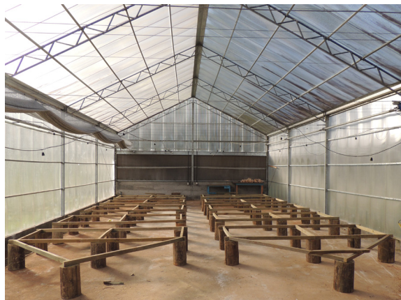
Figura 7. Estrutura de madeira para suporte dos tanques de produção de microalgas ( raceways ).
