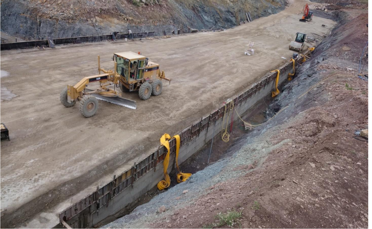
Şekil 1.5 Baraj gövde beton serimi
