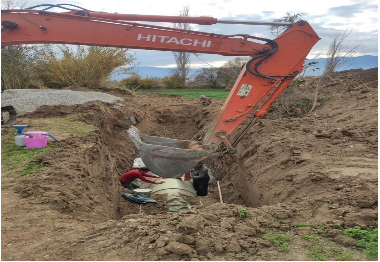
Şekil 2.3 CTP boru montajı
