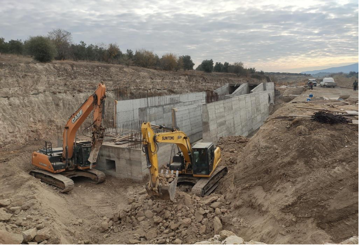
Şekil 2.3 Çökeltim Havuzu Yapımı
