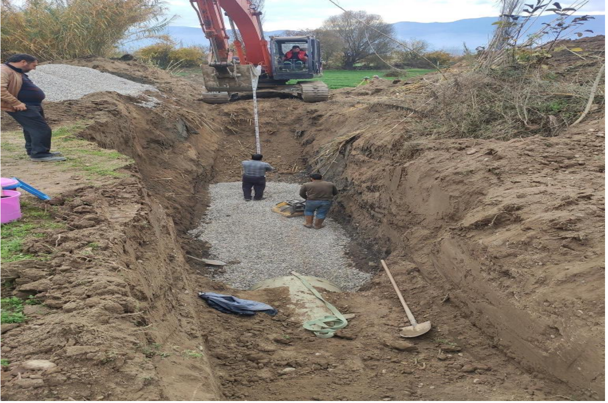
Şekil 2.2 Sulama hattı yastıklama imalatı
