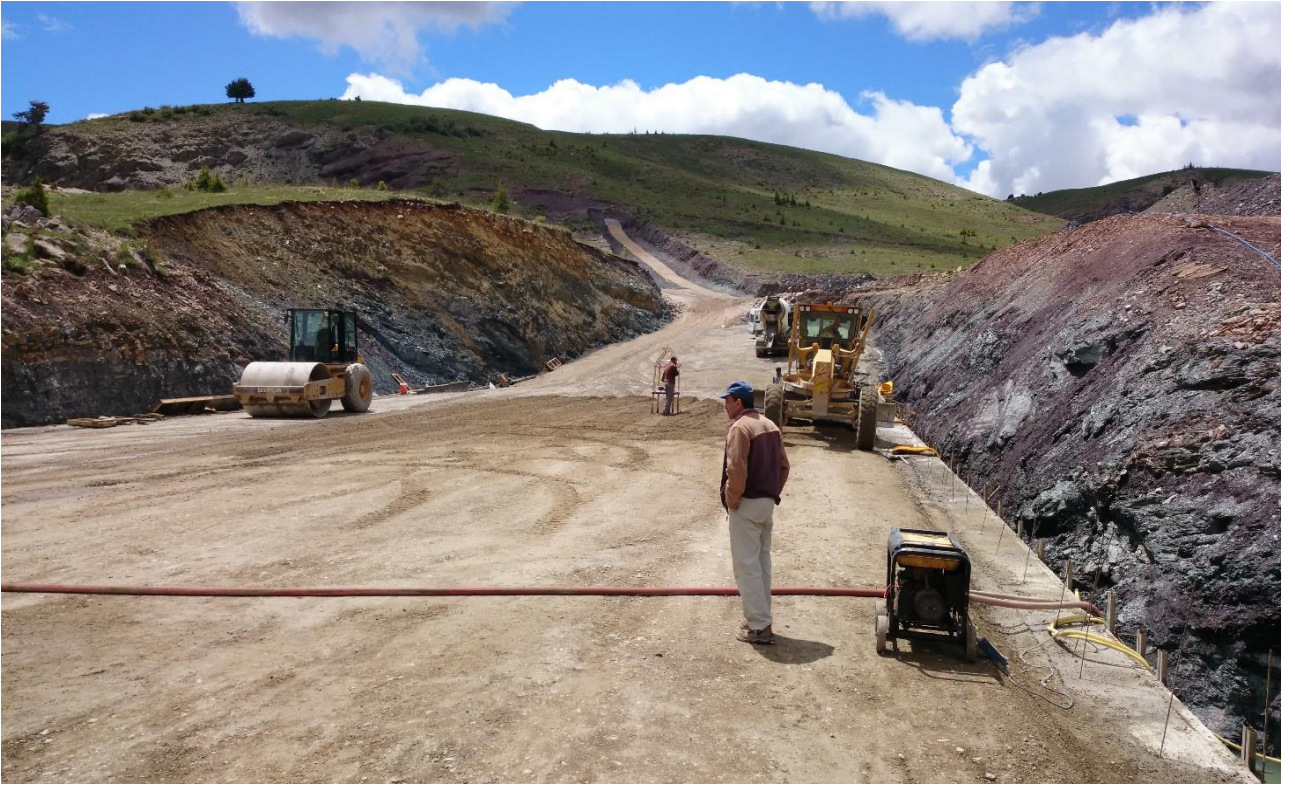
Şekil 1.7 Gövde beton serim ve sıkıştırma
