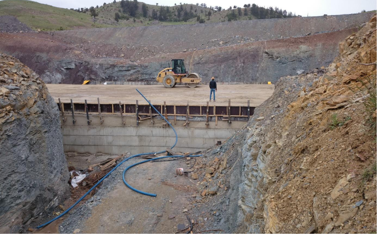
Şekil 1.4 Gövde beton sıkıştırma
