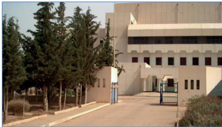
Figura 3. Edificio del reactor Es-Salam.
