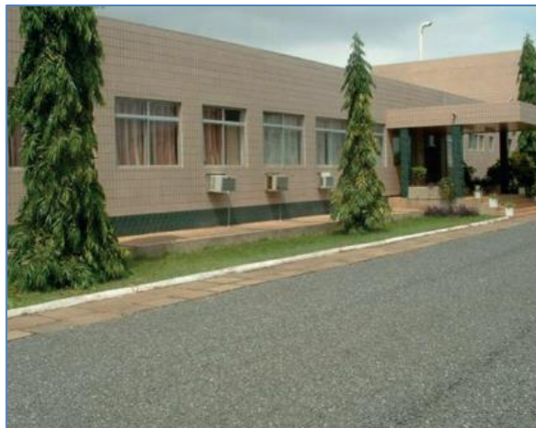
Figura 4. Edificio del reactor nuclear de investigación Gharr-1.
