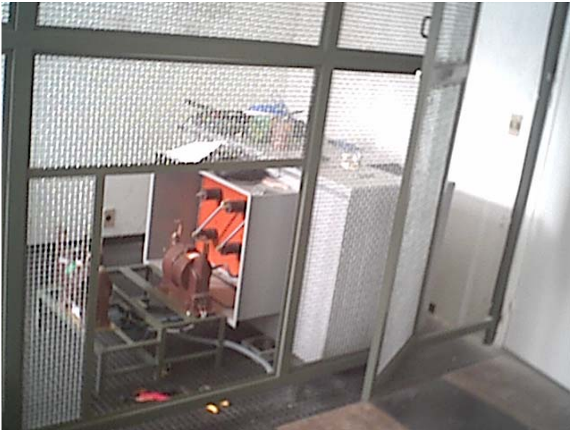
Figura 5.3 – Construção da mini Subestação – I
