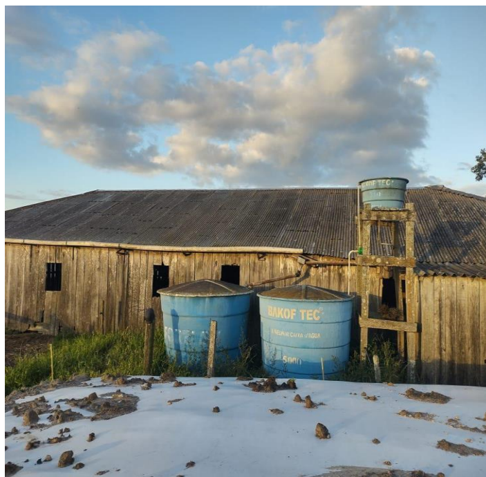
Figura 4: Caixas d'água ao lado do galpão de ordenha
