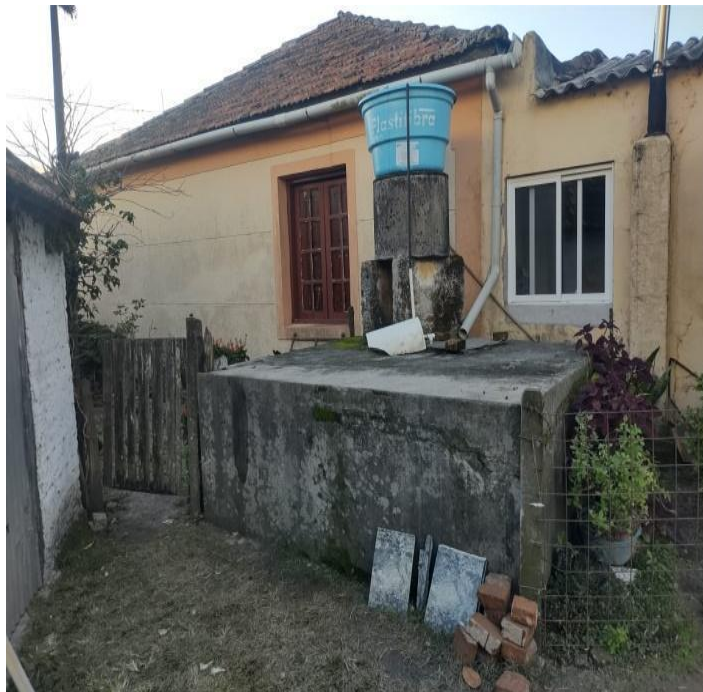
Figura 3: Algibe ao lado da residência
