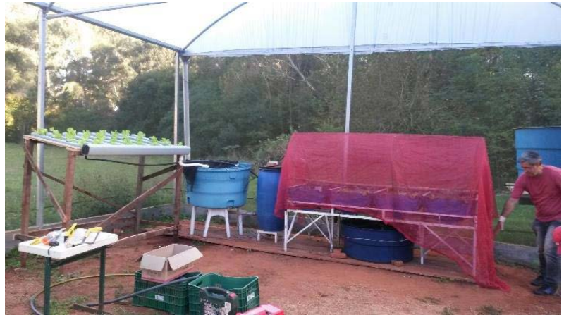
FIGURA 2. Montagem do sistema de 1000L
