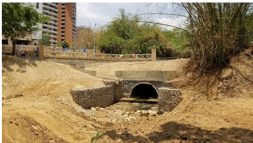
Figura 7.- Vista hacia aguas arriba una vez culminada la ejecución de la obra de reconstrucción de la alcantarilla (a color). Fuente: Autores.
