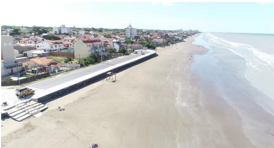
Figura 6.- Gabião aplicado como proteção costeira na praia de Santa Teresita, Argentina
