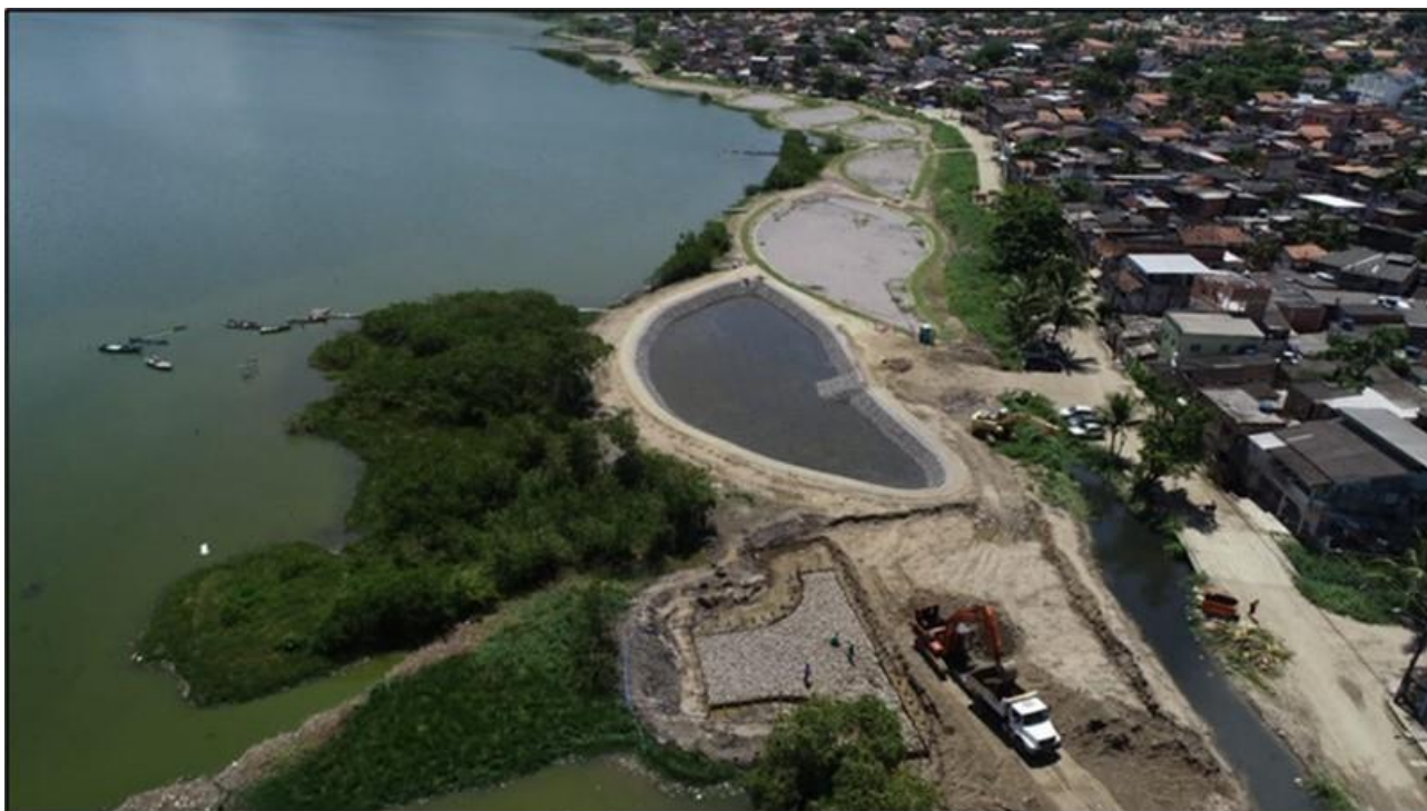
Foto 1.- Sistema de Jardins Filtrantes do Rio Arrozal em construção Fonte: as autoras
