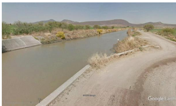
Figura 1. Canal de riego Antonio Coria, Guanajuato México. Fuente: Google Earth, 2022.
