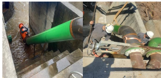
Figura 7.- Execução da instalação do sistema de geração.
