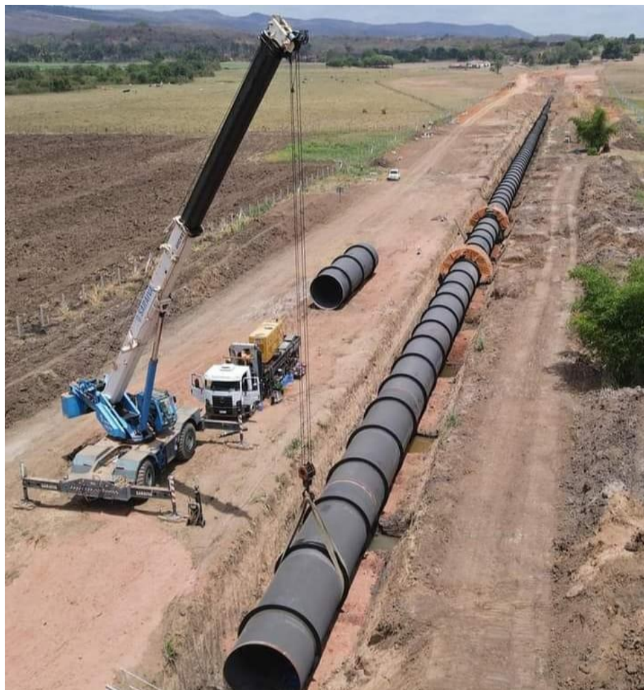
Figura 3.- Assentamento da tubulação Fonte: Autora (2022)
