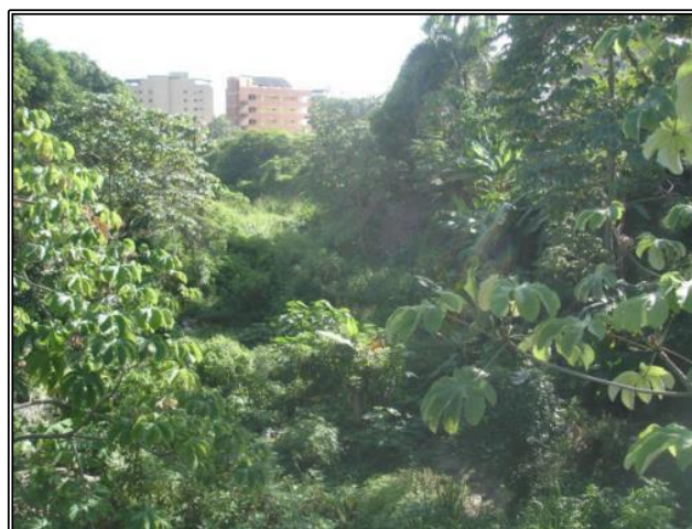
Figura 22.- Vista hacia aguas abajo del Puente de la Av. La Playa. (Julio 2019). (Foto cortesía Ing. José Marañón)
