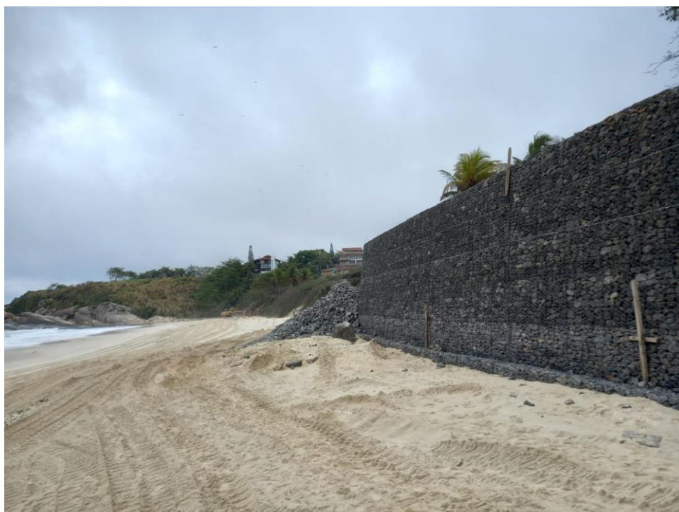
Figura 12.- Execução da proteção costeira
