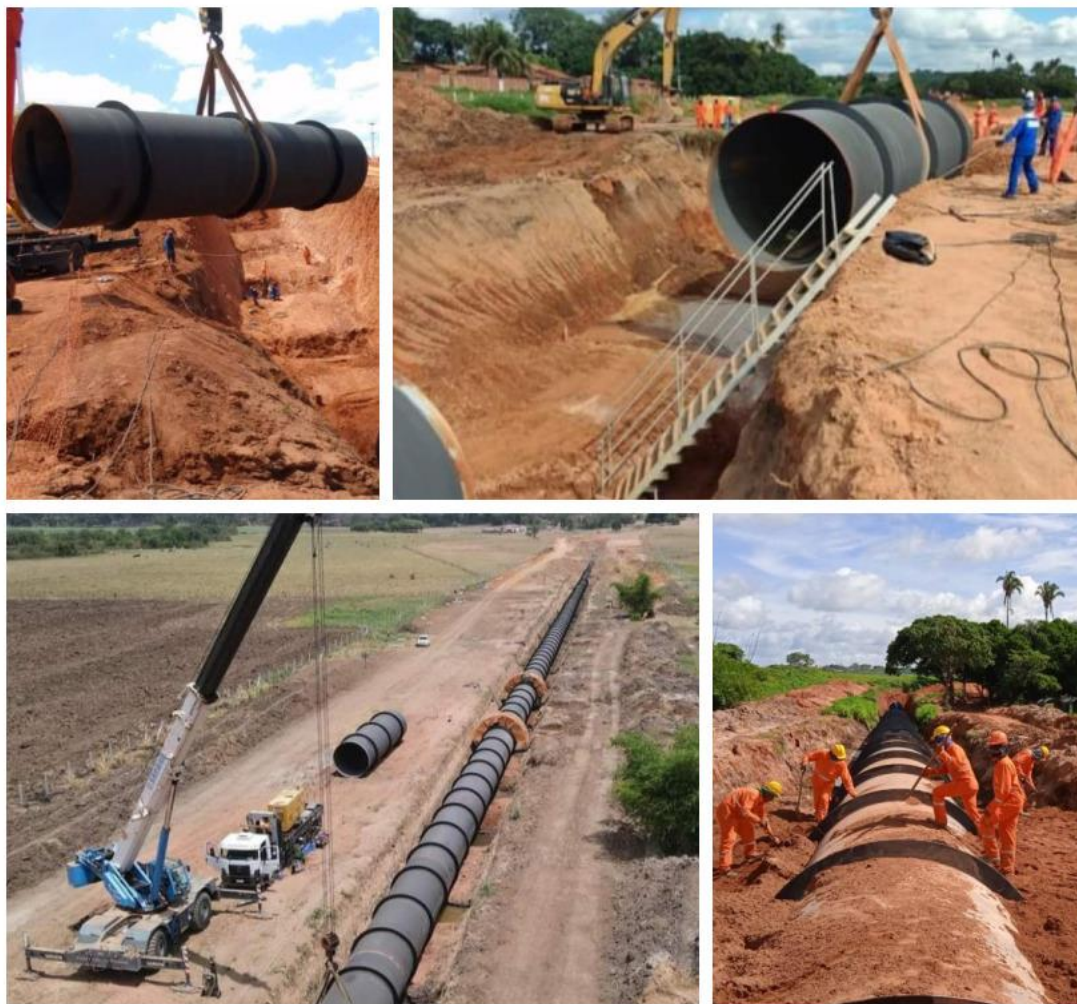
Figura 1.- Fases do assentamento da tubulação. Fonte: Autora (2022)
