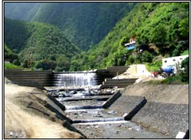
Figura 6.- Vista de la canalización y de la presa de retención. (Noviembre 2004)
