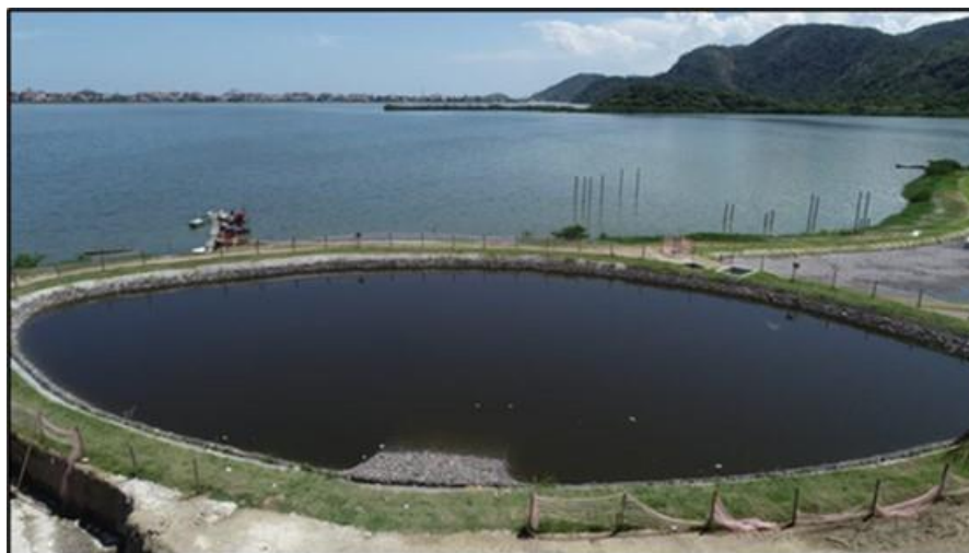
Foto 4.- Bacia de Sedimentação já em funcionamento Fonte: as autoras.
