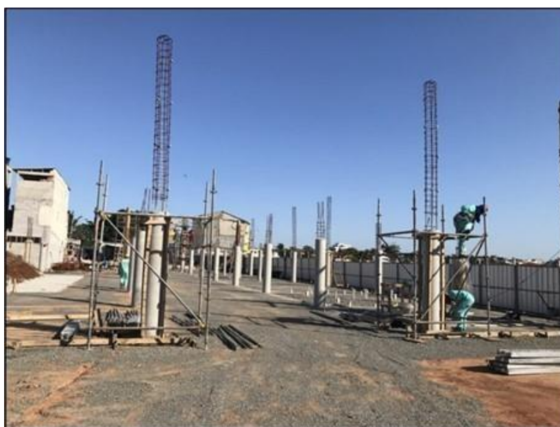
Foto 7.- Obras do Centro Ecocultural do POP em andamento Fonte: as autoras
