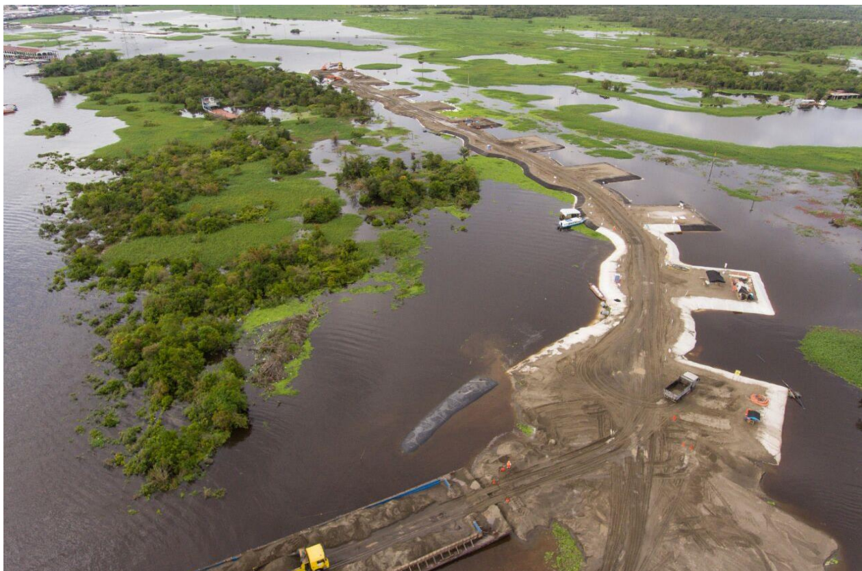
Figura 6 - Vista geral da obra
