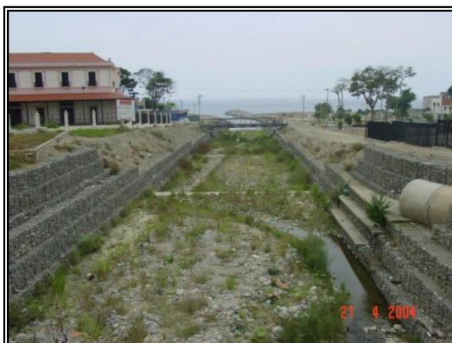
Figura 10.- Vista de la canalización desde el puente de la Av. La Playa hacia la descarga al mar. (Noviembre 2004).
