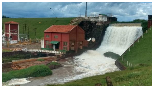
Figura 2.- Detalhes da estrutura existente na CGH Pari Veado. Fonte: HIGRA (2022)
