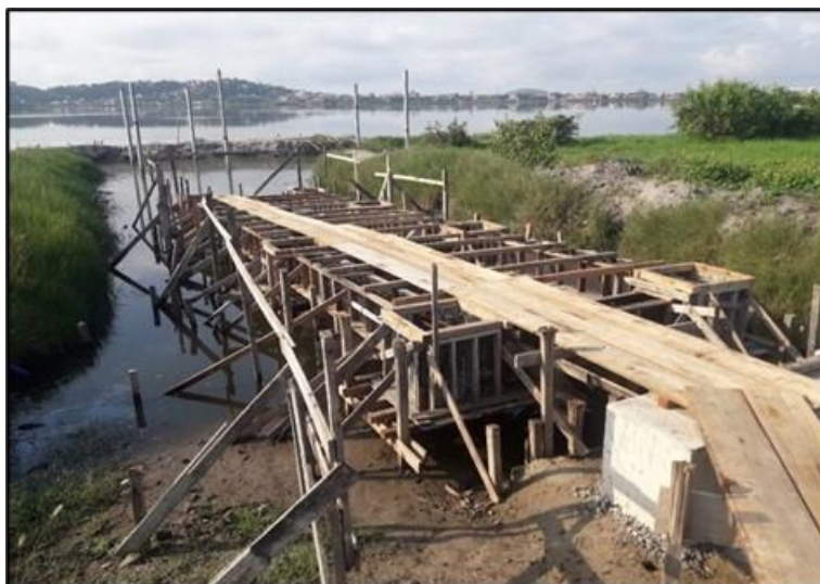
Foto 8.- Obras em andamento do píer de contemplação do Cafubá Fonte: as autoras.
