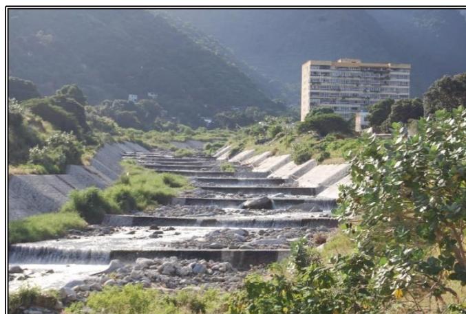
Figura 25.- Vista de la canalización del Río San Julián. Obsérvese que las traviesas están en buenas condiciones, por lo que el comportamiento de las traviesas con revestimiento de roca cementada ha sido satisfactorio. (Septiembre 2019). (Foto cortesía Ing. José Marañón)
