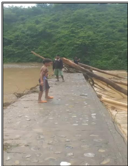
Figura 29.- Vista de la cresta del vertedero de la presa recubierta con roca cementada, la cual está en perfecto estado después de la crecida de septiembre de 2021.
