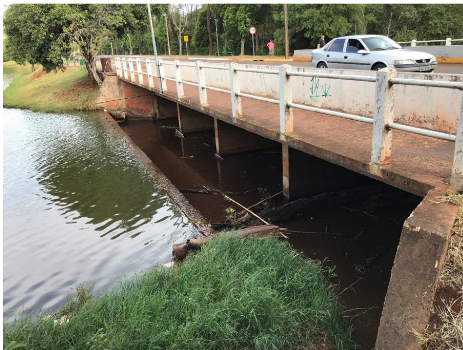
Figura 4.- Visão da Ponte e Vertedor atual Fonte: Autores, 2021.
