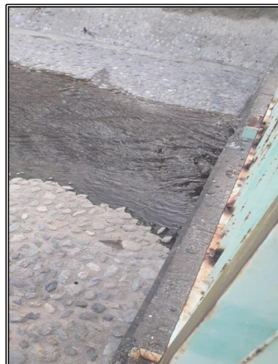
Figura 31.- Vista en detalle del revestimiento en roca cementada, el cual está en perfecto estado después de la crecida de septiembre de 2021.
