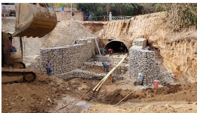
Figura 6.- Construcción de muros y obras de protección longitudinal (a color). Fuente: Autores.
