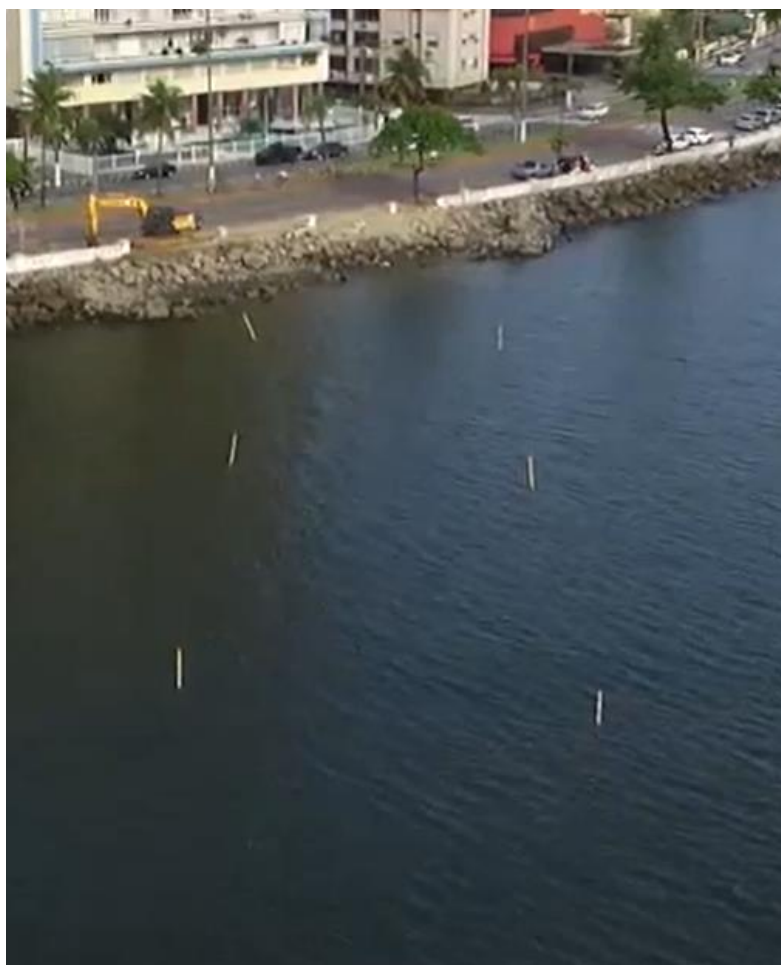
Figura 7. - Estacas de madeiras(dolphins) instaladas para dar início a instalação dos tubos geotêxtil. Fonte: Submar Dragagens, 2021.
