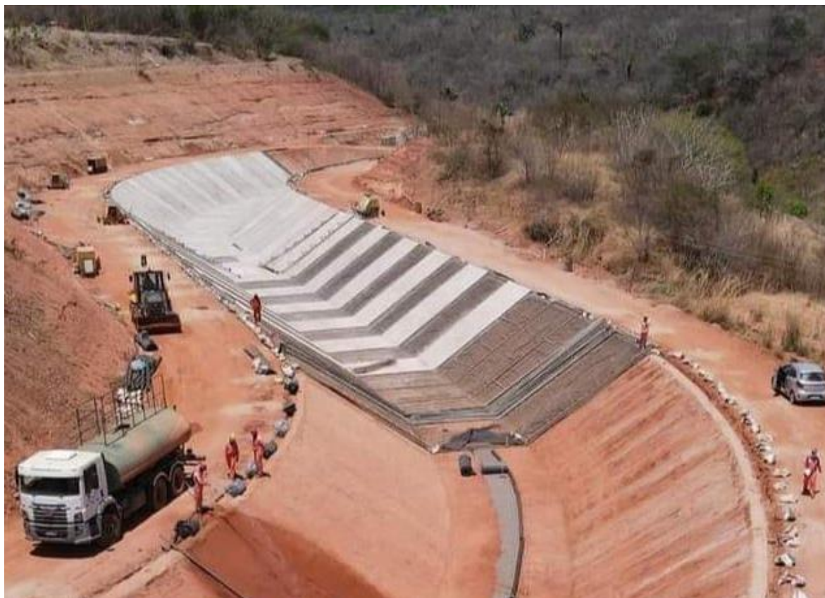
Figura 4.- Execução de canal trapezoidal Fonte: Autora (2022)
