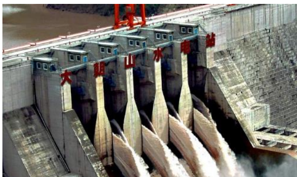
Figura 2.- Vertedouro da usina de Daschaoshan (China) em operação. (Muller et al , 2018)
