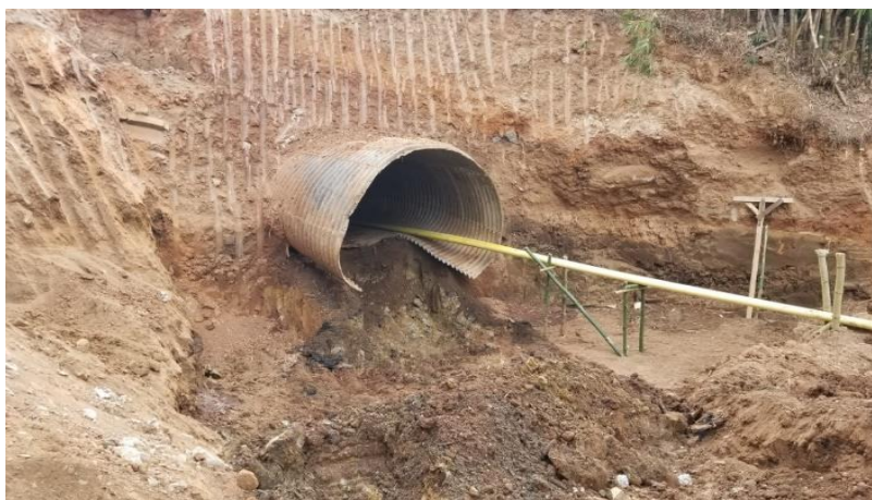
Figura 5.- Obras de saneamiento de la base de la alcantarilla (a color). Fuente: Autores.
