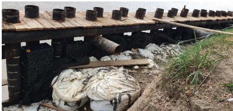
Figura 15.- Vista de la Estructura con Flotanks y Relleno en Geobolsas.
