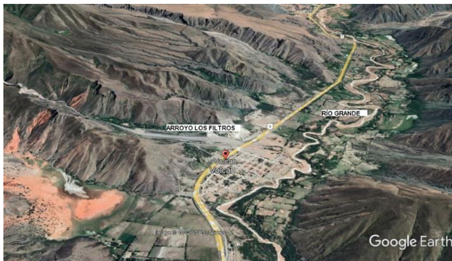
Figura 9.- Localidad del Volcán y puente sobre el Arroyo Los Filtros.
