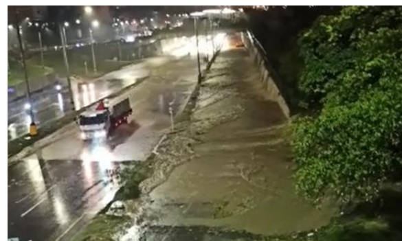
Figura 3.- Inundación túneles viales Parques del Río, 05/04/2021.
