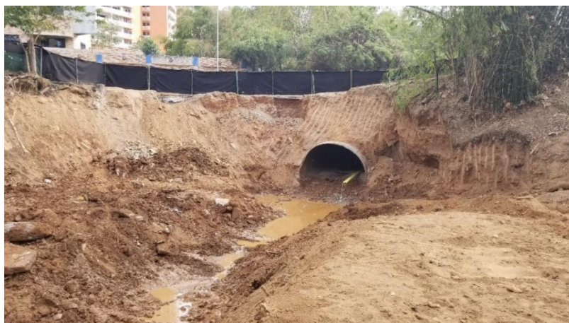
Figura 3.- Vista hacia aguas arriba de la descarga de la alcantarilla posterior a los trabajos preliminares de limpieza del área afectada (a color). Fuente: Autores.
