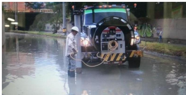
Figura 1.- Inundación intercambio vial a desnivel Minorista, 16/07/2015. Fuente: https://www.elcolombiano.com/ .
