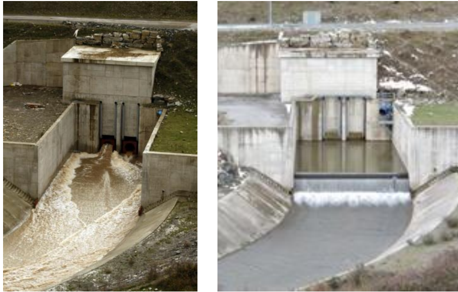
Figura 67.- Imágenes del cuenco inicial, y tras la construcción de un azud de salida de 2 m.
