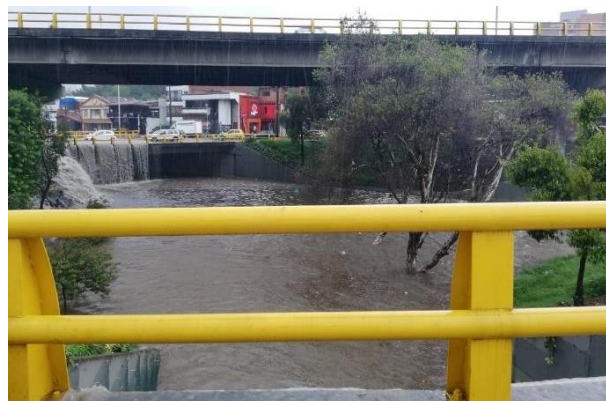
Figura 2.- Inundación intercambio vial a desnivel Bulerías, 22/11/2019. Fuente: fotografía del autor.
