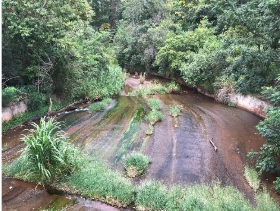
Figura 6.- Vertedor e sangradouro da barragem Fonte: Autores, 2021.
