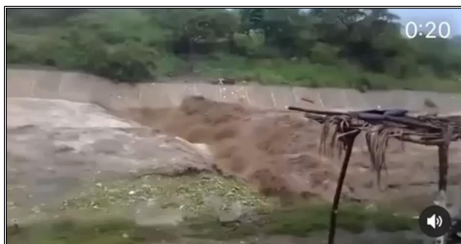
Figura 28.- Vista de la crecida en el Río Camuri Grande ocurrida en septiembre de 2021.- (Video Cortesía de los habitantes del Barrio Camuri y recopilado por el Ing. Alejandro Liberatore).
