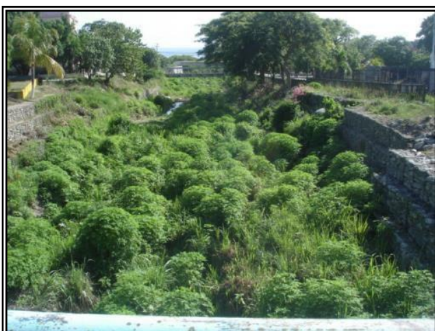
Figura 11.- Vista de la canalización desde el puente de la Av. La Playa hacia la descarga al mar. Obsérvese la vegetación de arbustos medianos que ocupa el cauce de la canalización. (Julio 2019) (Foto cortesía Ing. José Marañón)
