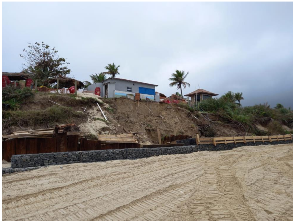
Figura 11.- Execução da proteção costeira
