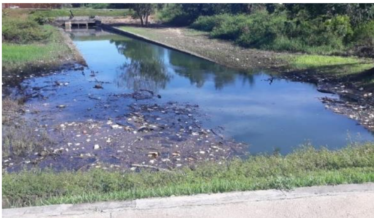
Figura 2.- Canal de drenagem próximo ao Rio Branco.
