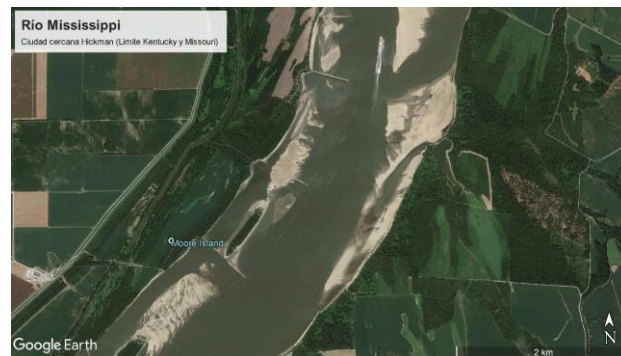
Figura 2. Obras rígidas de regularización en la hidrovía Mississippi.
