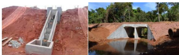
Figura 2.- Tipos de bueiros (a) de greide e (b) de grota
