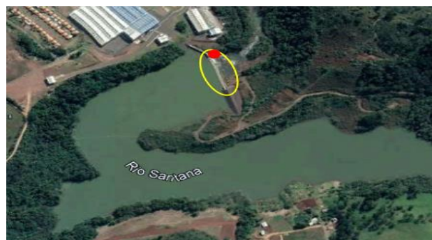
Figura 1.- Localização do barramento (circulado em amarelo) e descarga da vazão sanitária (ponto vermelho). Fonte: Google Earth.
