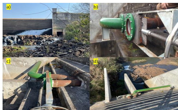
Figura 2.- Detalhes da estrutura existente no barramento.
