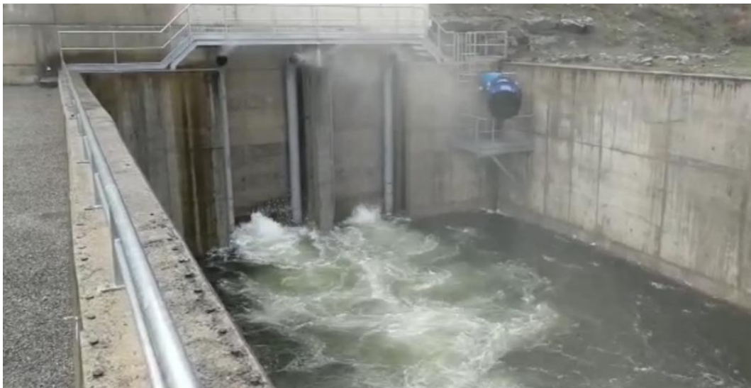
Figura 66.- Salida de los conductos al cuenco de amortiguamiento.
