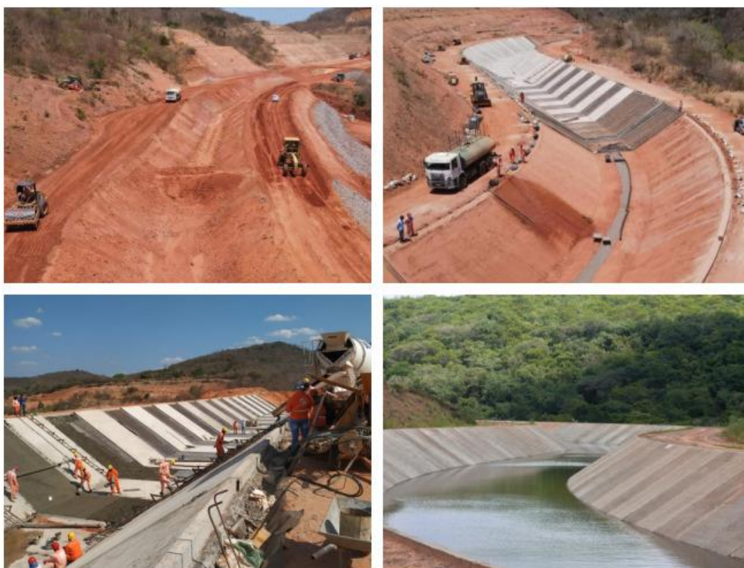
Figura 2.- Execução do conduto livre. Fonte: Autora (2022)
