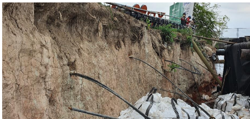
Figura 16.- Vista de los Anclajes en el Talud de la Orilla
