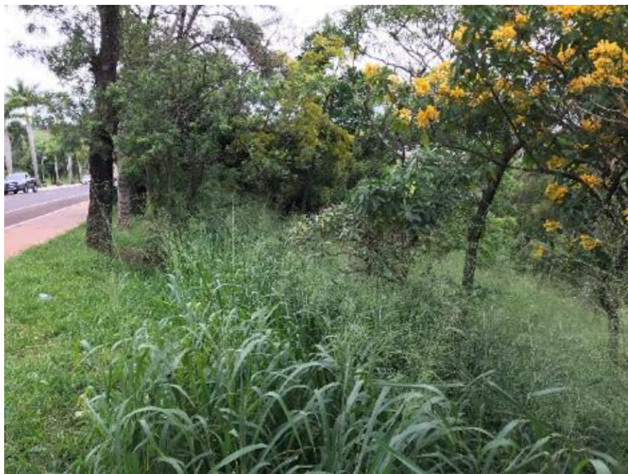
Figura 5.- Vegetação em Talude de jusante Fonte: Autores, 2021.
