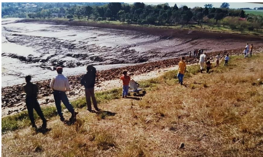
Figura 3.- Vista a partir da Crista da barragem após esvaziamento do lago Fonte: CASINI, 2021.
