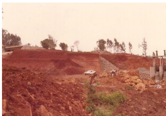
Figura 12.- Imagem da execução da barragem do Lago do Jaboti descarregador de fundo. Fonte: SOUZA, 2021.
