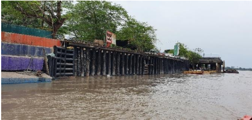
Figura 12.- Vista de las Obras de Protección en Construcción
