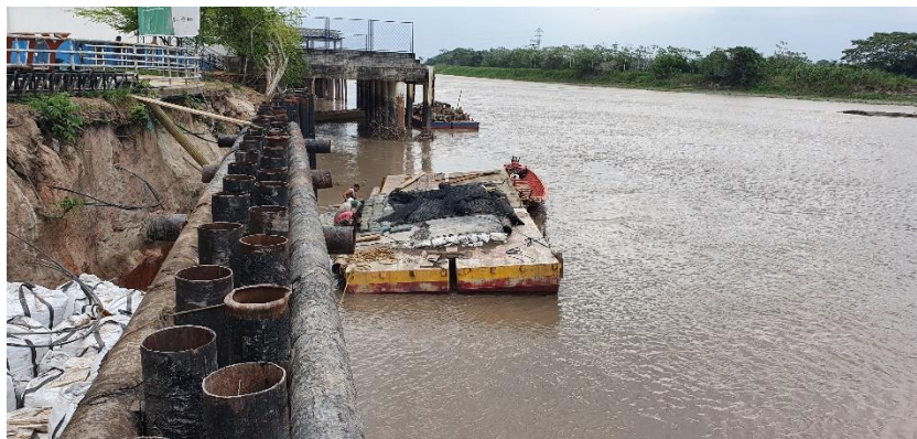
Figura 14.- Vista de la Conformación y Colocación de la Geostera
