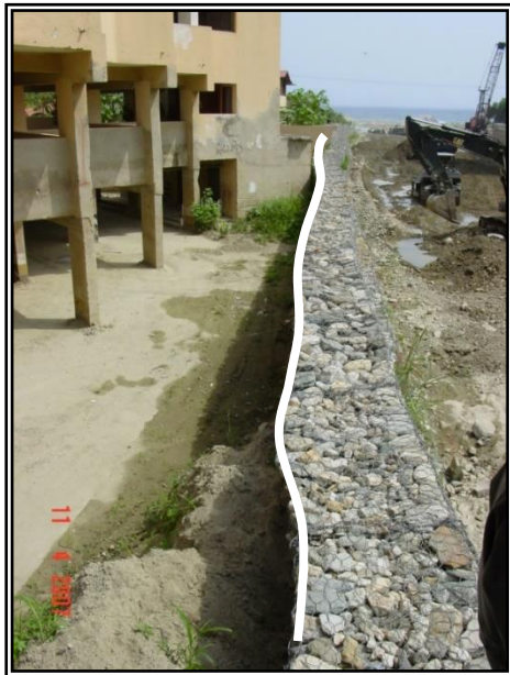
Figura 16.- Análisis comparativo de superposición entre la sección de proyecto y la sección construida en la Sección Transversal Prog. 0 + 329,38.
