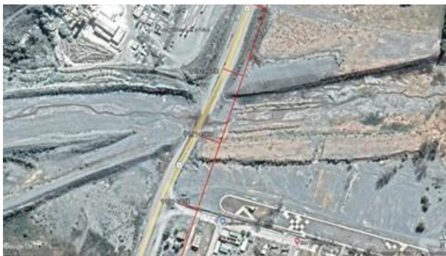
Figura 10.- Puente sobre el Arroyo Los Filtros (GoogleEarth)
