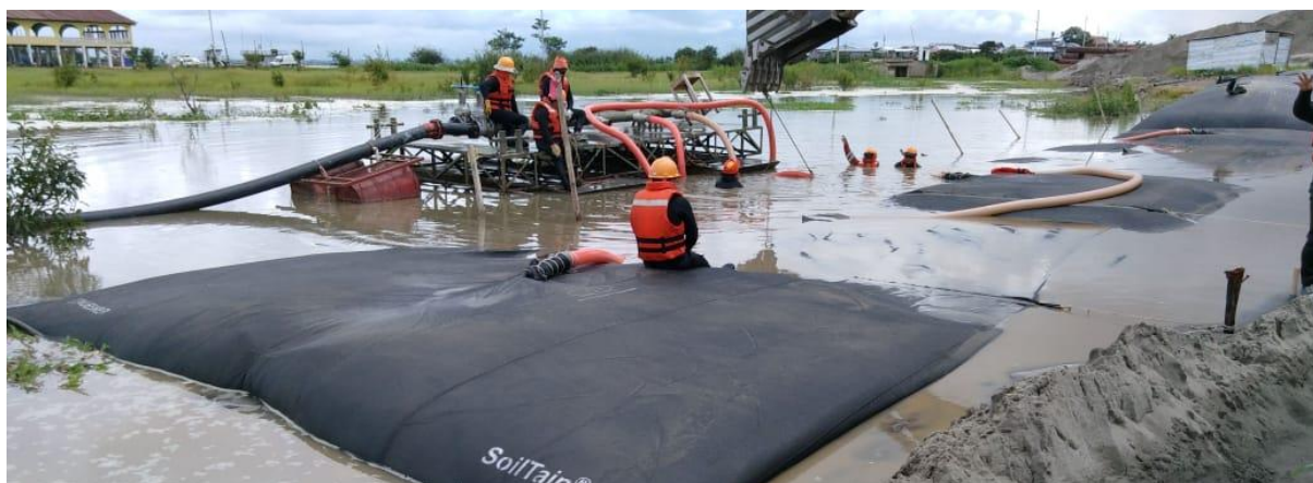
Figura 5 - Preenchimento dos tubos geotêxteis
