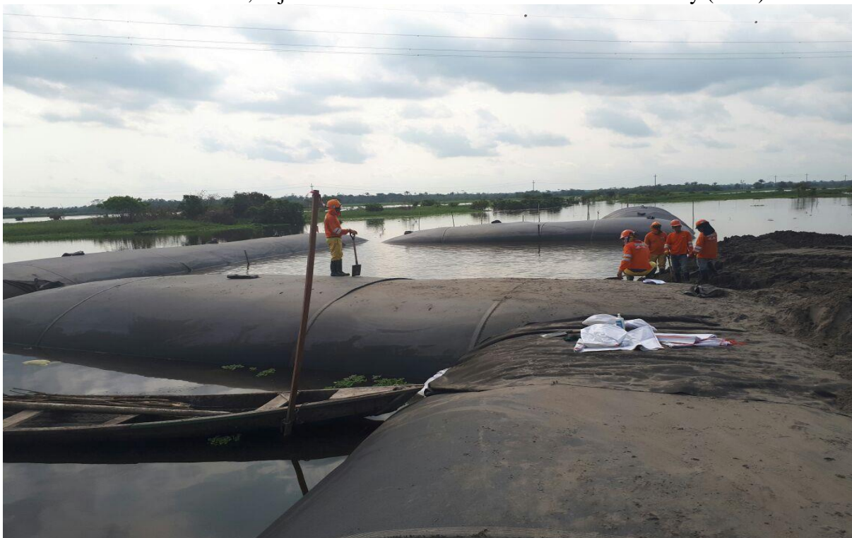
Figura 2 - Aterro interior arenoso na contido pelos diques laterais com tubos geotêxteis
