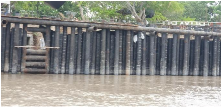
Figura 13.- Vista de la Cortina de Pilotes y Flotanks en Etapa Constructiva
