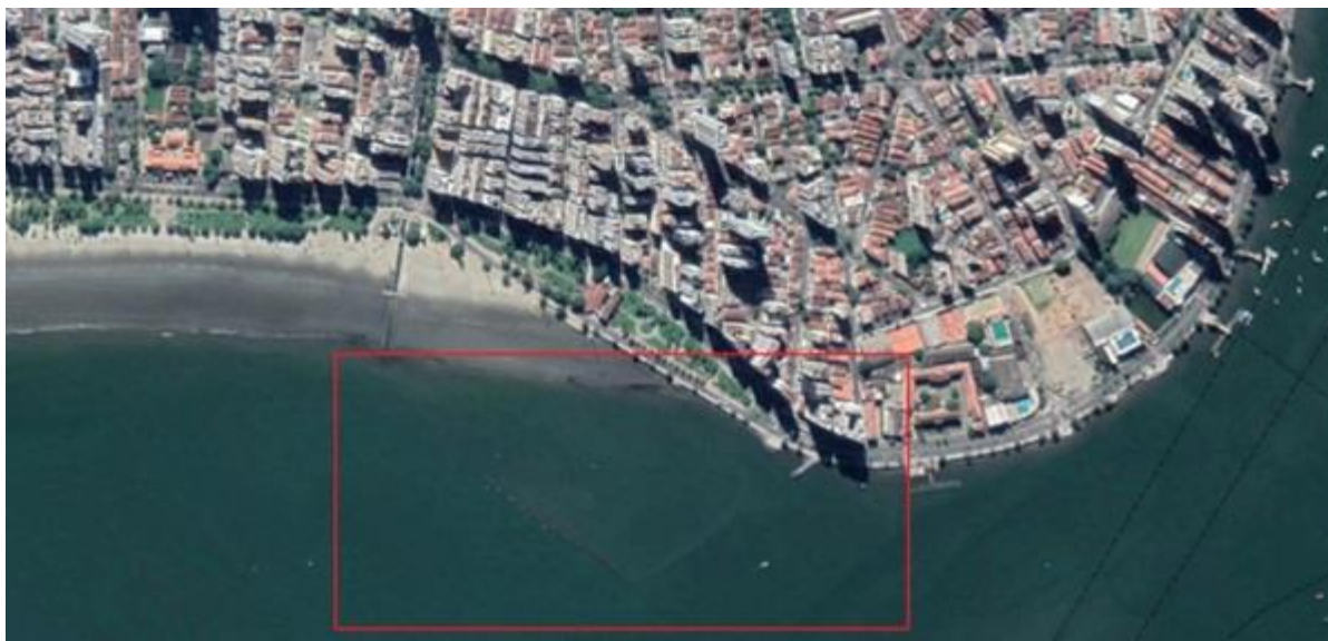
Figura 3.- Imagem de satélite da obra já instalada na região. Fonte: adaptado de Google Earth®.
