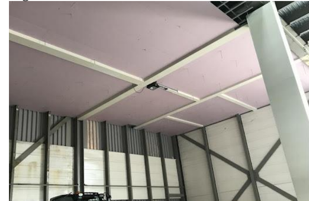
Figura 33. Techo con construcción en Enviroboard
