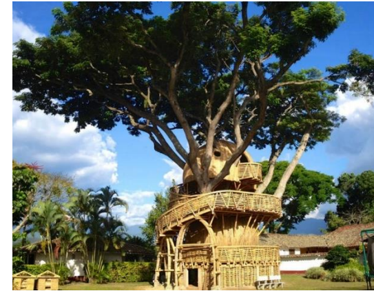
Figura 28 Casa en el árbol De Guadua en Cundinamarca, Colombia
