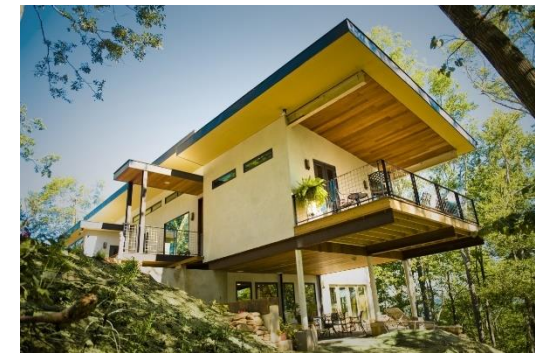
Figura 31 Casa de Hempcrete en Asheville, Carolina del Norte
