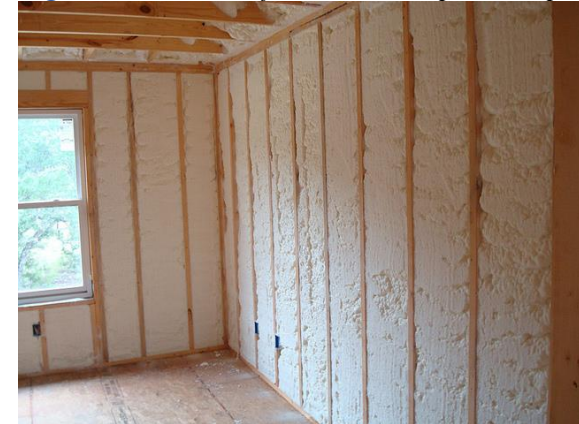
Figura 32 Pared Reforzada con Espuma de poliuretano
