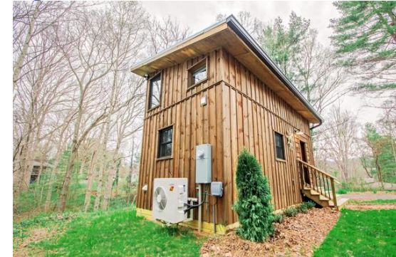
Figura 25 Casa de NANOSTEAD, en Carolina del Norte
