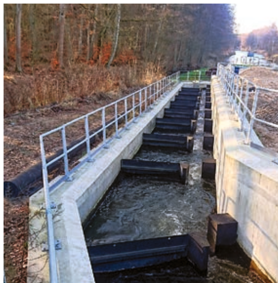
Abbildung 9: Vom WSA Lauenburg neu erstellte Fischaufstiegsanlage nahe Malliß in der Müritz-Elde-Wasserstraße
