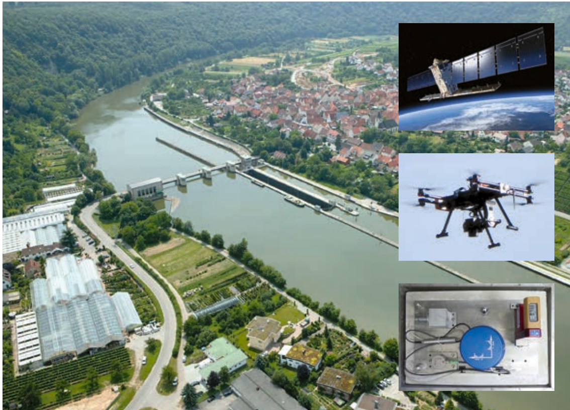
Abbildung 38: Neue ingenieurgeodätische Systeme zum Monitoring von Verkehrsinfrastrukturbauwerken
