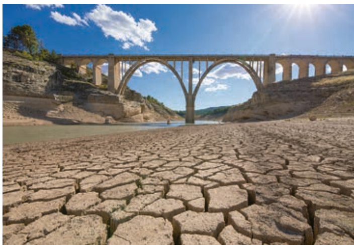
Abbildung 105: Zunehmende Dürren wie hier am Entrepeñas-Stausee in Spanien sind eine der Folgen des Klimawandels im Mittelmeerraum. (Quelle: Q/Adobe Stock)
