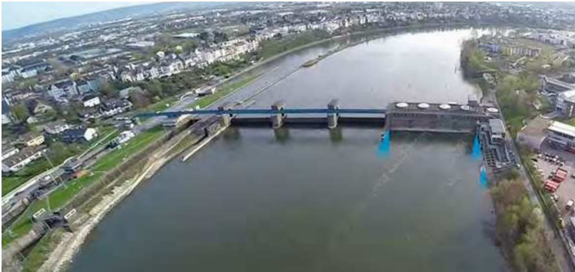
Abbildung 112: Beispiel Stauanlage; potenzielle Positionen von FAA-Einstiegen mit blauem Leitströmungssymbol gekennzeichnet. © GFGmbH, Mainz
