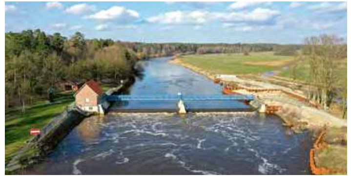
Abbildung 118: Schlauchwehr in Bannetze an der Aller – Untersuchungsstandort für den Fischabstieg.
