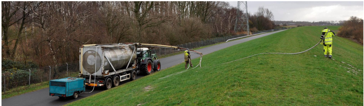
Abbildung 21: Vergießen von Rissen im Kaltehofe Hauptdeich, Hamburg (Jordan 2018).
